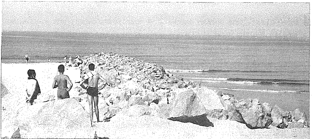
Fig.I.1 - Esporão marítimo (primeiro esporão construído na Cova do Vapor)
