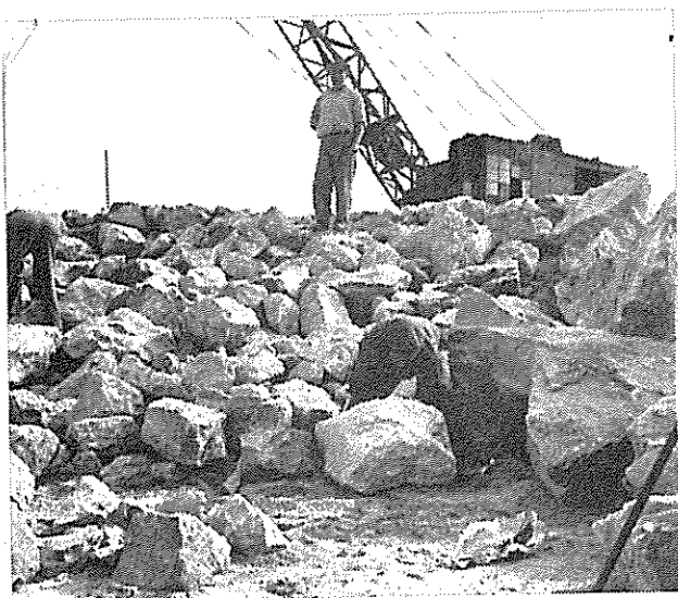
Fig.III.12 - Pormenor da construção do esporão E2
