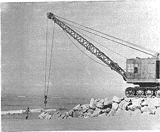
Fig.III.1 - Construção do esporão E3
