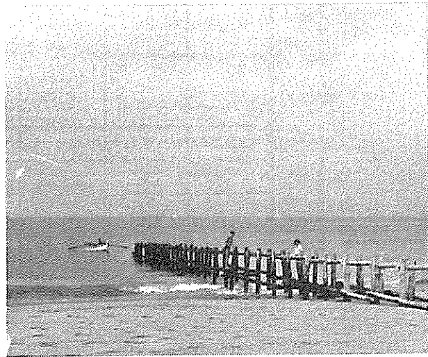
Fig.III.2 - Estrutura do esporão de madeira (fase de ruína)
