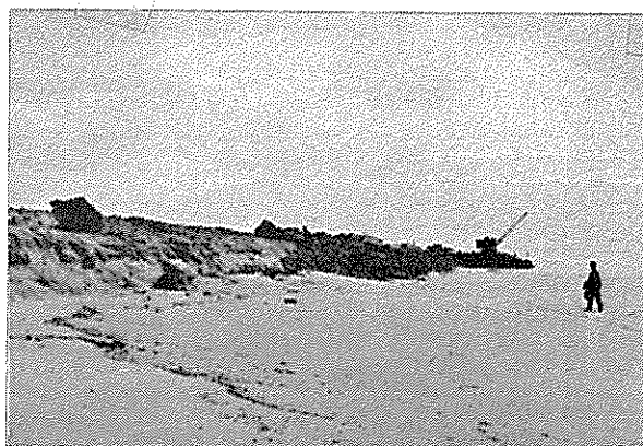
Fig.III.7 - Obras de emergência para defesa da Caparica (Fevereiro de 1965)
