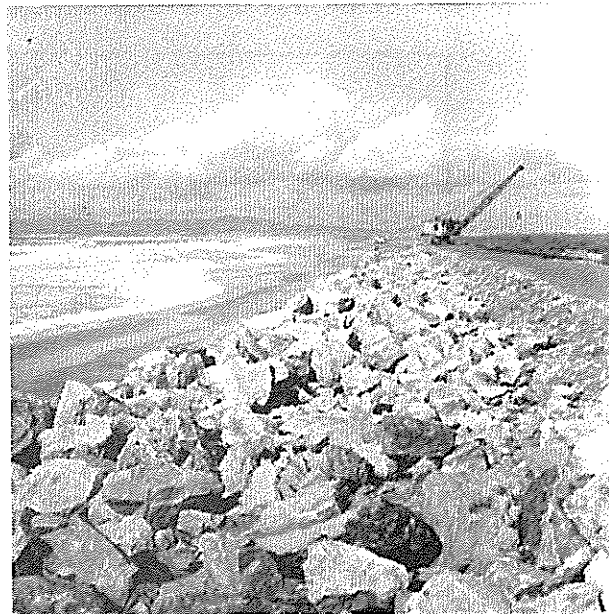
Fig.III.4 -Reforço do dique da Costa da Caparica (Janeiro de 1965)
