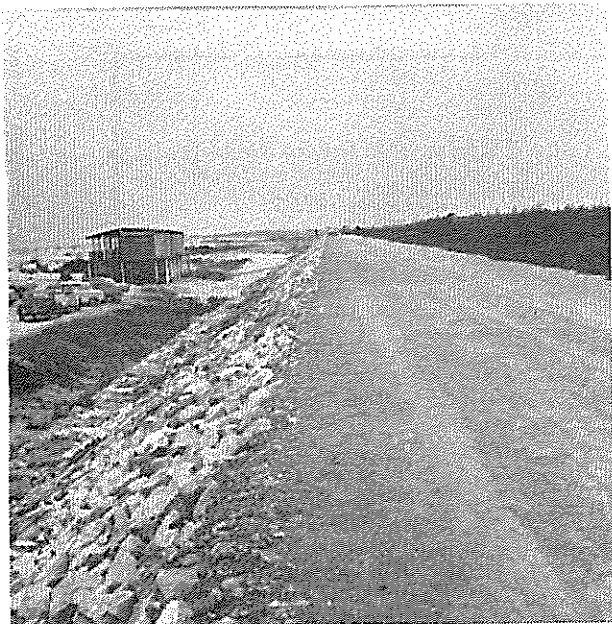
Fig.III.3 -Dique da Costa da Caparica (Agosto de 1962)
