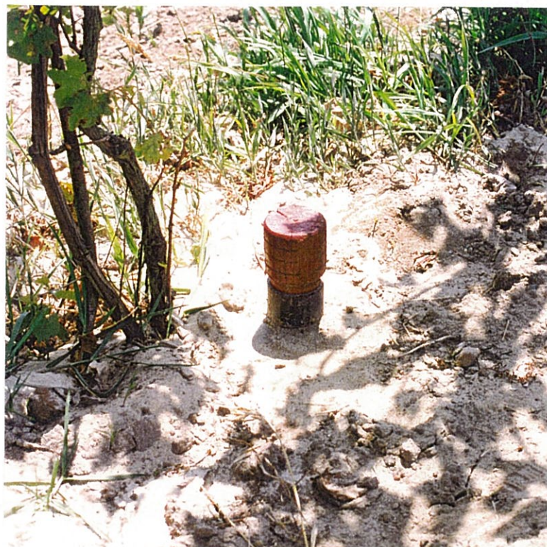
Foto 1 - Furo de injeção de água em Estarreja
