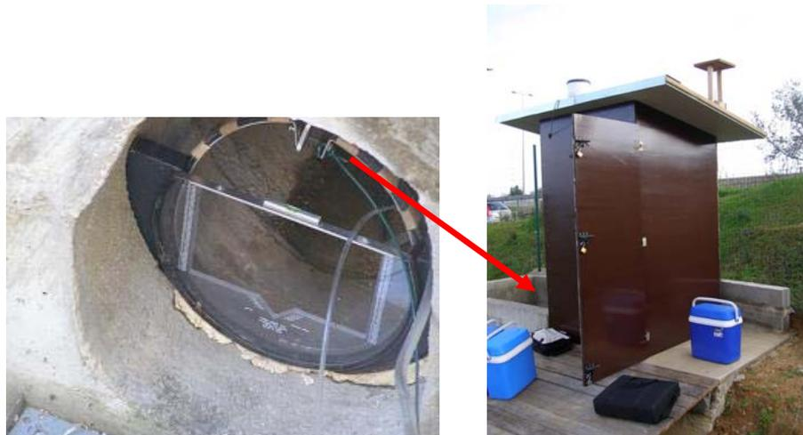
Figura 3 – Descarregador The-Mar instalado no colector e abrigo com o restante equipamento.
