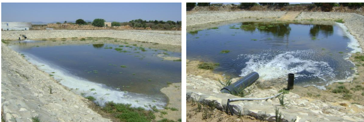
Figura 6 – Vista geral de uma das três bacias da estação de recarga artificial de Korba localizada no sistema aquífero da Costa Oriental (Cap Bon – Tunísia) com um caudal de alimentação de 1500 m 3 /dia
