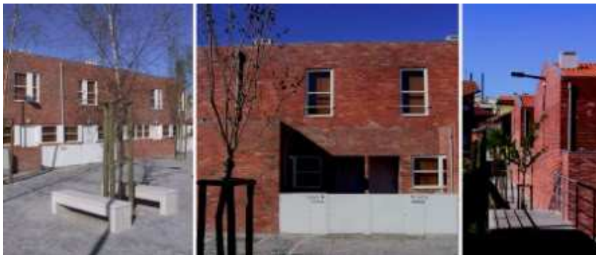
Fig. 01: as bandas contínuas de unifamiliares do pequeno Bairro do Telheiro, C. M. de Matosinhos, Arq. Manuel Correia Fernandes.
