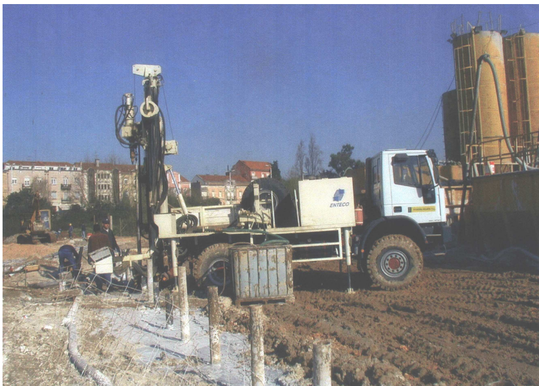
Foto 11 – Execução de uma sondagem num painel do Alinhamento Nascente.
