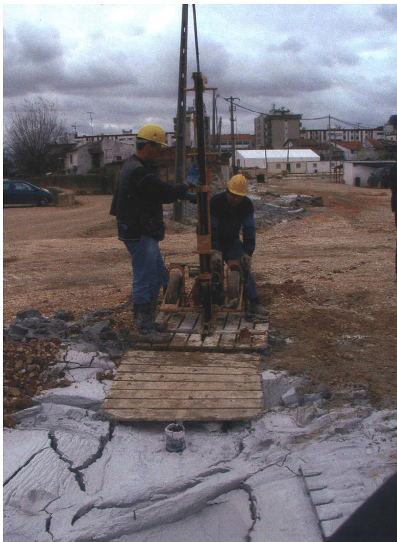
Foto 12 – Realização de um ensaio PDL num painel do Alinhamento Nascente, a 26 de Fevereiro de 2002.
