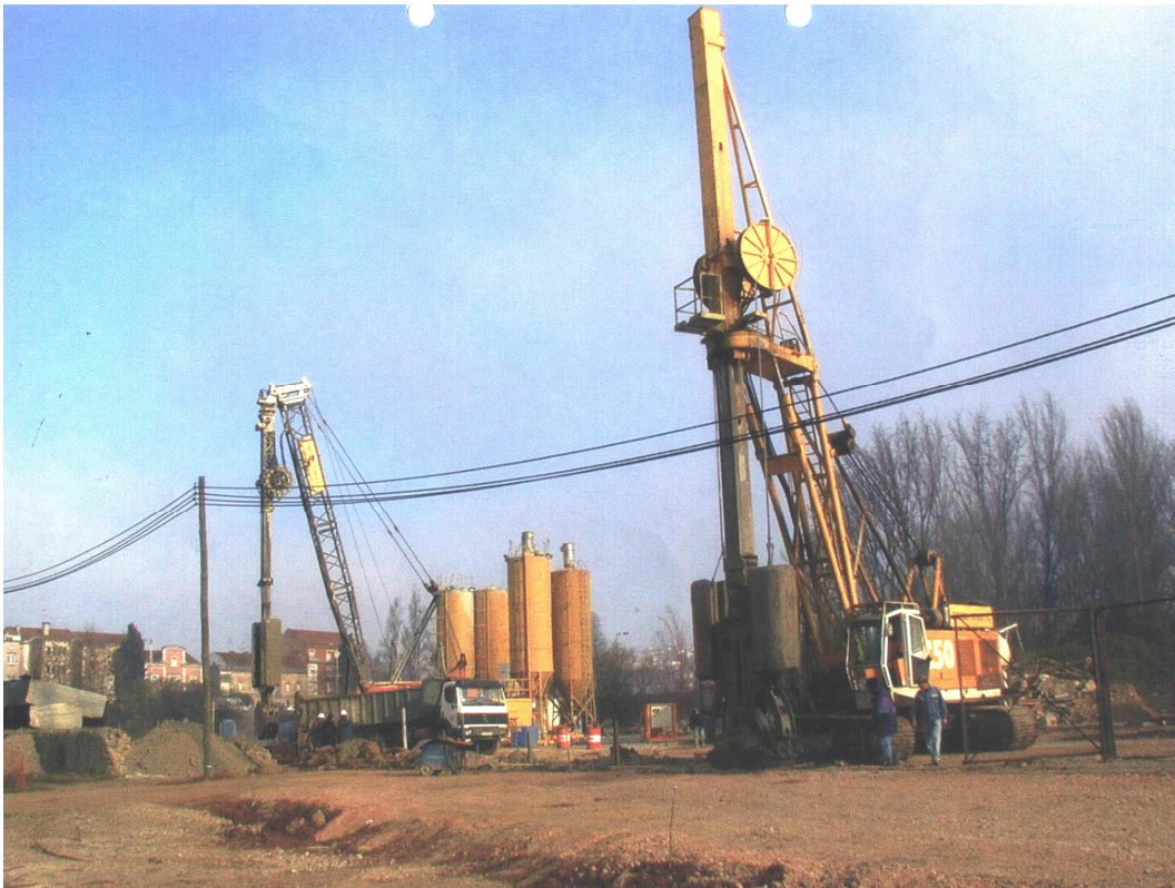
Foto 3 – Equipamento utilizado na escavação dos painéis.
