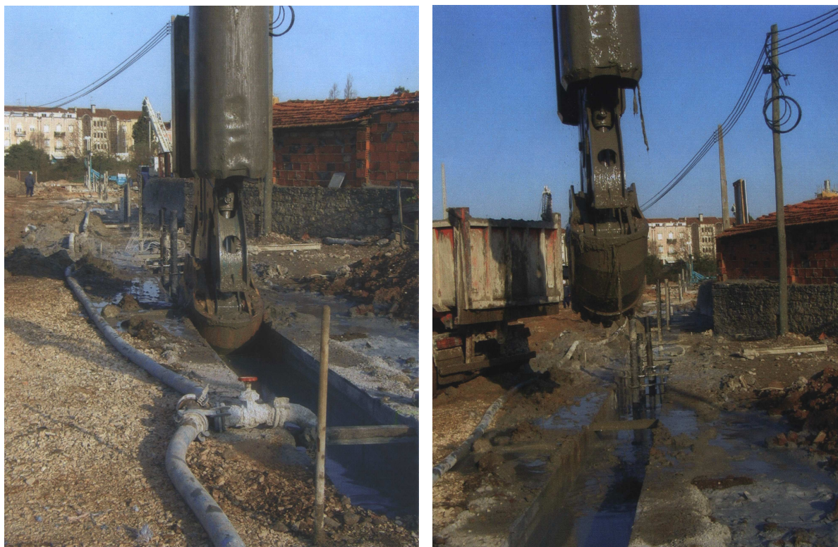
Foto 4 – Escavação de um painel de parede moldada auto-endurecedora no Alinhamento Nascente da cortina.
