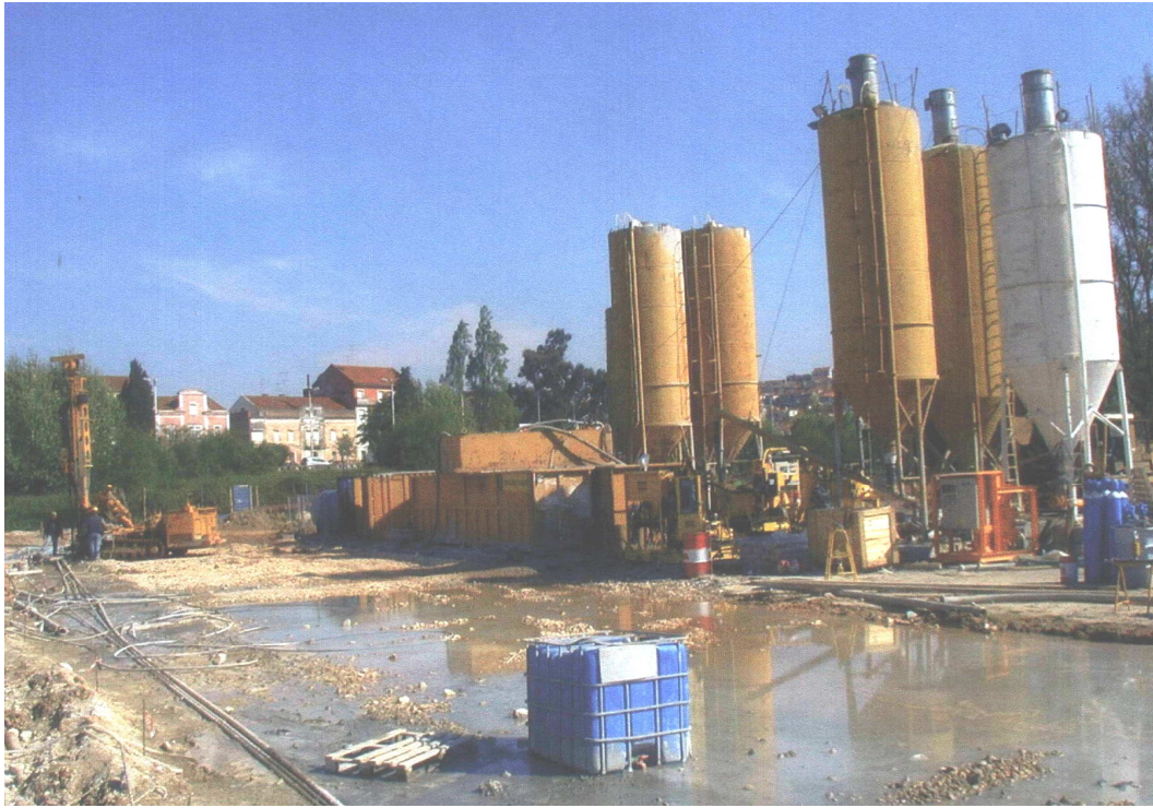
Foto 2 – Estaleiro de fabrico da calda auto-endurecedora.
