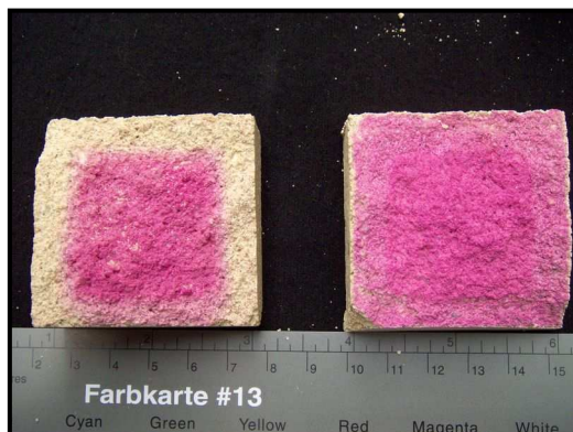
Figura 4.16 – Extensão da carbonatação de um provete antes dos restantes estarem sujeitos ao ambiente da câmara climática (à esquerda) e extensão da carbonatação de um provete depois de estar sujeito ao ambiente da câmara climática (direita)
