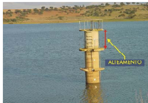
Fot. 6.8 - Barragem de Vale da Ursa. Torre de tomada do sistema de descarga de fundo e tomada de água. Assinalado o alteamento efectuado (COBA, 2001).
