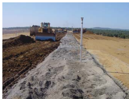
Pormenor dos aterros do núcleo, do filtro chaminé e do maciço de jusante.
