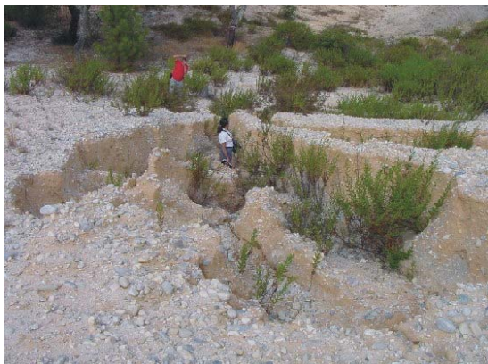
Fot. 4.5 - Barragem de Cadouços II (CIGB). Vista do encontro esquerdo, a jusante. Reconhecidos ravinamentos profundos (ELU 205) (COBA, 2001g).
