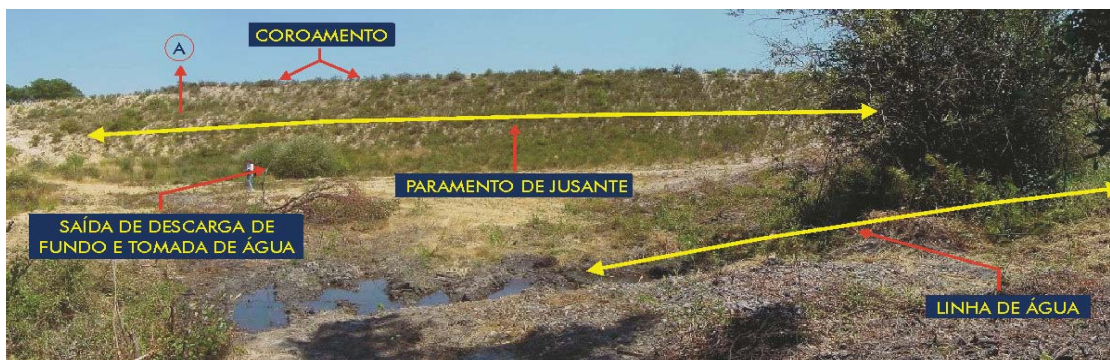
Fot. 6.13 - Barragem de Cadouços III. Vista geral do paramento de jusante (A - ressurgência a cota elevada) (COBA, 2001h).
