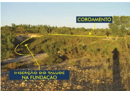
Fot. 6.29 - Barragem de Valeira Alta. Vista geral do paramento de jusante. Fotografia tirada para o encontro direito (COBA, 2001af).
