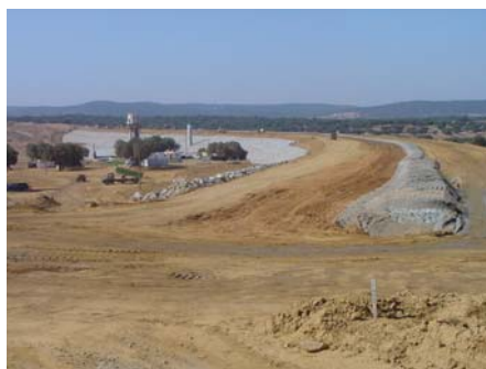
Vista geral dos aterros. Fotografia tirada do encontro direito.
