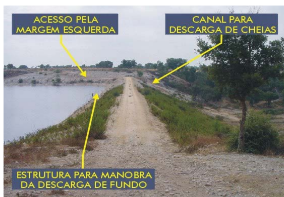
Fot. 6.9 - Barragem de Cadouços II. Vista geral do coroamento e dos taludes de montante e de jusante. Fotografia tirada para o encontro esquerdo (COBA, 2001g).
