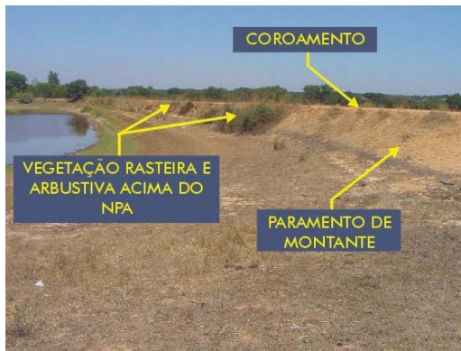
Fot. 6.32 - Barragem de Monte dos Alhos. Vista geral do paramento de montante. Fotografia tirada para o encontro esquerdo (COBA, 2001i).
