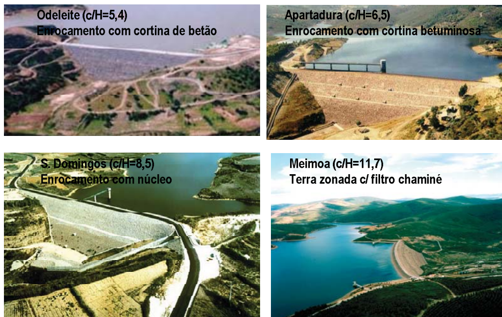
Fig. 4.7 – Exemplos de barragens de aterro portuguesas e relações corda-altura dos respectivos vales (fotografias do site da CNPGB, http://cnpgb.inag.pt/gr_barragens/gbportugal ).
