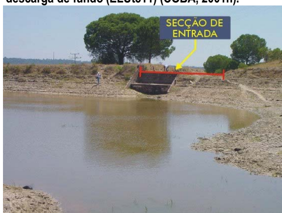
Fot. 4.50 - Barragem da Terça (RSB). Vista parcial do talude de montante e da entrada do descarregador de cheias. Fotografia tirada da margem direita da albufeira. Alargamento da secção original do descarregador de cheias por erosão do terreno natural à direita, por insuficiente capacidade de vazão do descarregador (ELUt509) (COBA, 2001n).
