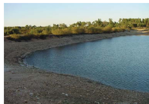
Fot. 6.28 - Barragem de Valeira Alta. Vista geral do paramento de montante. Fotografia tirada da margem esquerda da albufeira (COBA, 2001af).
