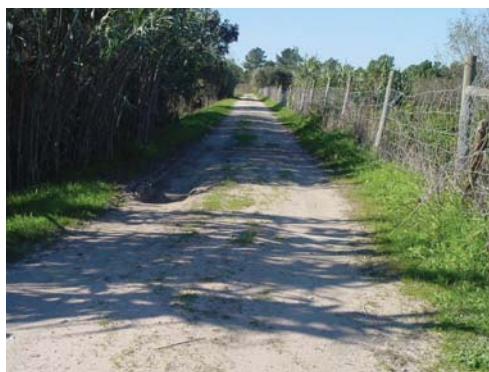
Fig. 6.20 - Barragem de Vale Sanceiro. Vista geral do coroamento. Fotografia tirada para o encontro esquerdo (COBA, 2001ac).
