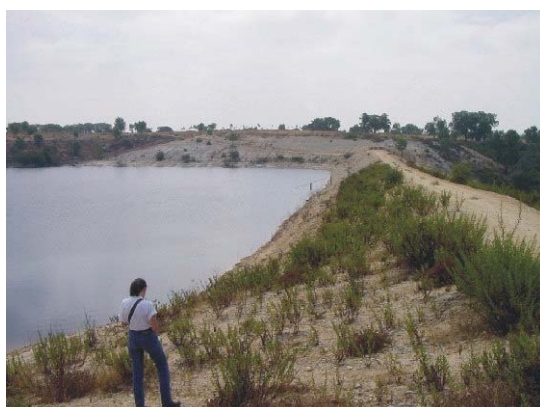
Fot. 4.11 - Barragem de Algalé II (RSB). Vista do coroamento. Fotografia tirada para o encontro esquerdo. Reconhecida fendilhação excessiva longitudinal (ELU407) (COBA, 2001f).
