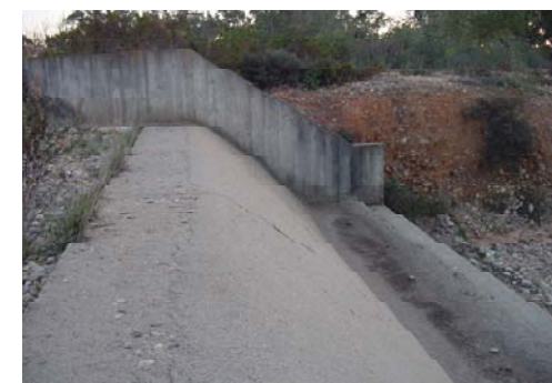
Fot. 6.30 - Barragem de Valeira Alta. Vista geral do descarregador de cheias. Fotografia tirada do muro lateral direito (COBA, 2001af).
