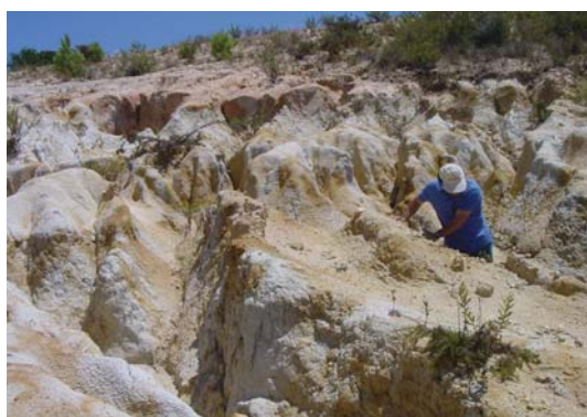
Fot. 6.15 - Barragem de Cadouços III. Ravinamentos profundos no encontro direito, imediatamente a jusante do aterro da barragem (COBA, 2001h).
