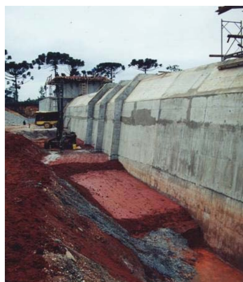
Fot. 7.16 – Barragem do Iraí. Vista de pormenor dos aterros argilosos do núcleo em contacto com a galeria dos órgãos hidráulicos (Vazquez, 2002).
