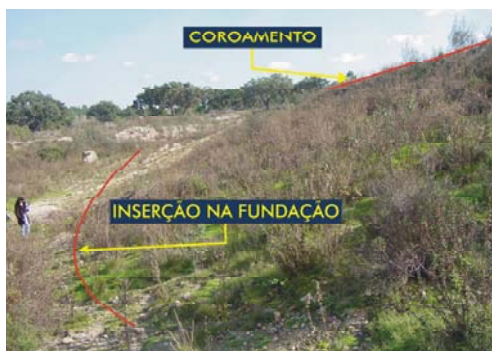
Fot. 6.25 - Barragem de Vale Pinheiro. Vista do paramento de jusante e inserção da barragem na fundação (encontro direito e vale central) (COBA, 2001ae).
