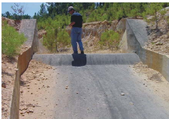
Fot. 6.18 - Barragem de Covões. Vista da soleira descarregadora. Visível algum material arrastado dos taludes confinantes para o interior do canal. Fotografia tirada para montante (COBA, 2001j).
