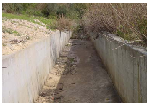
Fot. 6.26 - Barragem de Vale Pinheiro. Vista do canal do descarregador de cheias. Fotografia tirada para jusante (COBA, 2001ae).
