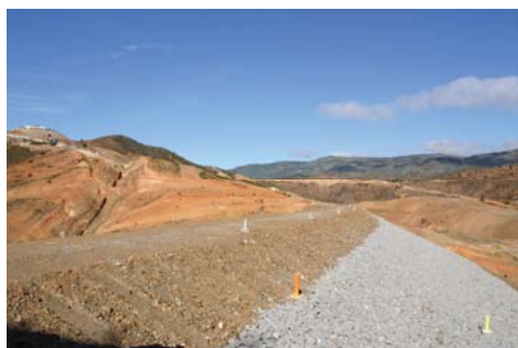
Fot. 7.10 – Ensecadeira de Odelouca. Vista do paramento de montante e do coroamento (Fotografia da autora, tirada para o encontro direito, em 09/09/2005).
