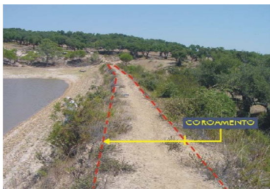
Fot. 6.1 - Barragem da Terça. Vista geral do coroamento. Fotografia tirada do encontro direito (COBA, 2001n).
