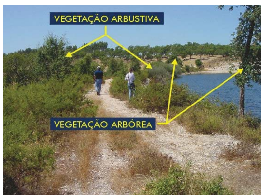
Fot. 4.14 - Barragem de Cadouços I (RSB). Vista do coroamento. Fotografia tirada para o encontro direito. Reconhecido desnivelamento excessivo do coroamento na zona central, de maior altura dos aterros (ELU408), fissuração e fendilhação longitudinal (ELUt409) e vegetação arbustiva e arbórea (ELUt411) (COBA, 2001k).
