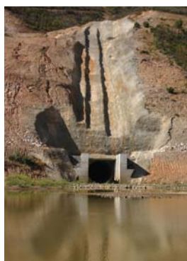
Fot. 7.12 – Ensecadeira de Odelouca. Vista da entrada da galeria de derivação (Fotografia da autora, em 09/09/2005).
