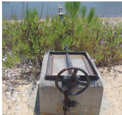
Fot. 6.19 - Barragem de Covões. Vista do volante de manobra da comporta de tomada de água e descarga de fundo. Fotografia tirada do coroamento (COBA, 2001j).
