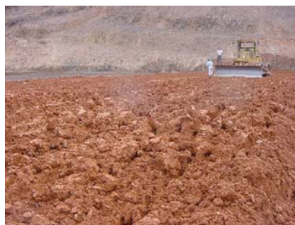
Fot. 7.8 – Ensecadeira de Odelouca. Vista duma camada do núcleo com a compactação concluída (Fotografia tirada em 04/09/2003, COBA, 2003a).
