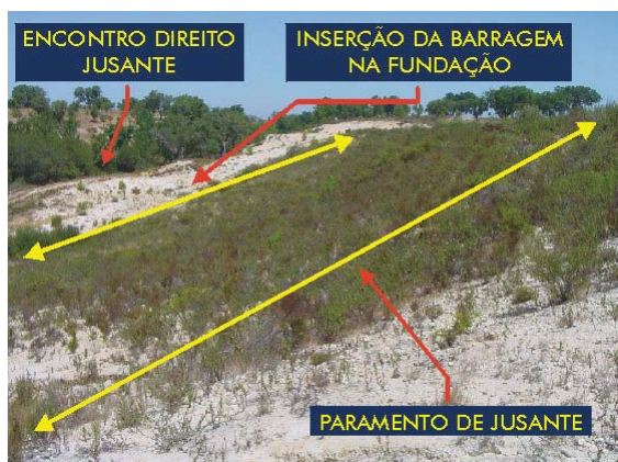
Fot. 4.22 - Barragem de Cadouços III (CIGB). Vista geral do paramento de jusante. Fotografia tirada do encontro esquerdo. Reconhecidos ravinamentos profundos (ELU406) e afluência de caudais excessivos (ELU405) (COBA, 2001h).
