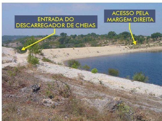
Fot. 4.45 - Barragem de Cadouços II (CIGB). Vista geral do talude de montante da barragem e da entrada do descarregador de cheias, escavado no terreno natural. Fotografia tirada da margem esquerda da albufeira, para jusante. Reconhecida erosão superficial do rasto e dos taludes que materializam a secção de entrada (ELU506) (COBA, 2001g).
