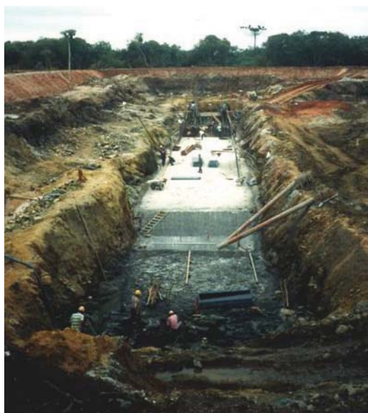
Fot. 7.15 – Barragem do Iraí. Vista geral da área de implantação dos órgãos hidráulicos em fase de execução dos betões de regularização e da soleira (Vazquez, 2002).
