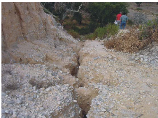
Fot. 4.45 - Barragem de Cadouços II (CIGB). Vista geral do talude de montante da barragem e da entrada do descarregador de cheias, escavado no terreno natural. Fotografia tirada da margem esquerda da albufeira, para jusante. Reconhecida erosão superficial do rasto e dos taludes que materializam a secção de entrada (ELU506) (COBA, 2001g).
