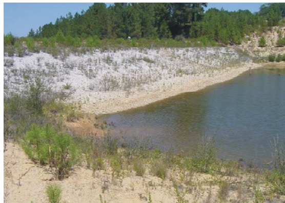
Fot. 6.17 - Barragem de Covões. Vista geral do paramento de montante. Fotografia tirada do encontro esquerdo (COBA, 2001j).
