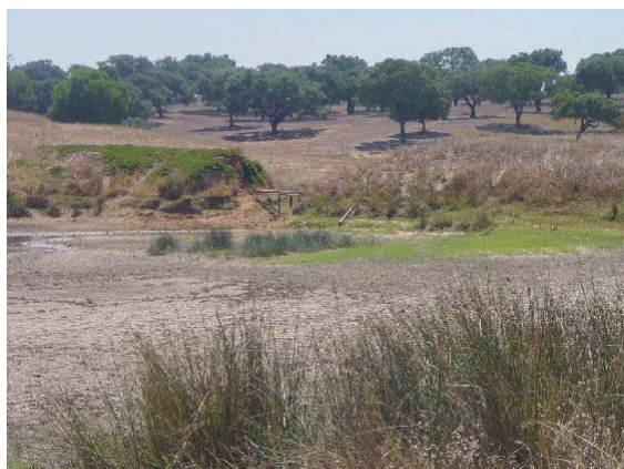
Fot. 4.22 - Barragem de Cadouços III (CIGB). Vista geral do paramento de jusante. Fotografia tirada do encontro esquerdo. Reconhecidos ravinamentos profundos (ELU406) e afluência de caudais excessivos (ELU405) (COBA, 2001h).
