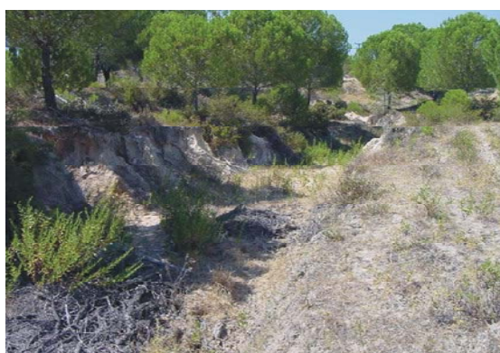
Fot. 6.3 - Barragem da Terça. Canal descarregador de cheias escavado no terreno natural. Fotografia tirada para montante (COBA, 2001n).
