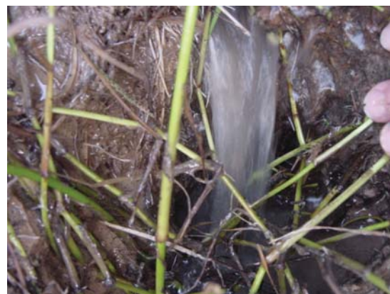
Fot. 4.19 - Barragem de Vale da Ursa (CIGB). Vista de pormenor do caudal efluente pelo principal ponto de emergência de água (ELU405) (COBA, 2001).
