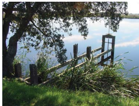
Fig. 6.21 - Barragem de Vale Sanceiro. Estrutura de apoio da haste de manobra da comporta de descarga de fundo. Visíveis as vigas e pilares do antigo passadiço (COBA, 2001ac).
