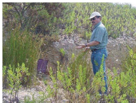
Fot. 4.21 - Barragem de Cadouços II (CIGB). Pormenor do rejeito da cicatriz de escorregamento (ELU411) (COBA, 2001g).
