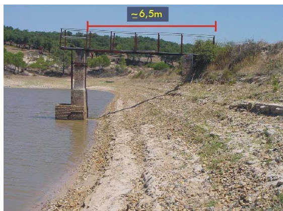
Fot. 4.27 - Barragem da Terça (RSB). Vista geral do passadiço de acesso à plataforma de manobras da comporta de tomada de água e descarga de fundo. Reconhecida corrosão de todos os elementos metálicos (ELU512) e deterioração excessiva do betão (ELU505) (COBA, 2001n).
