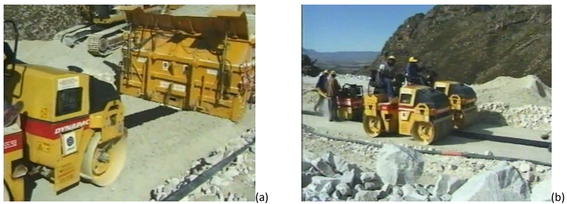
Figura 2.18 – Compactação da cortina interior e das camadas de transição: (a) aplicação das camadas de transição e imediata compactação; (b) vista geral dos cilindros compactadores.
