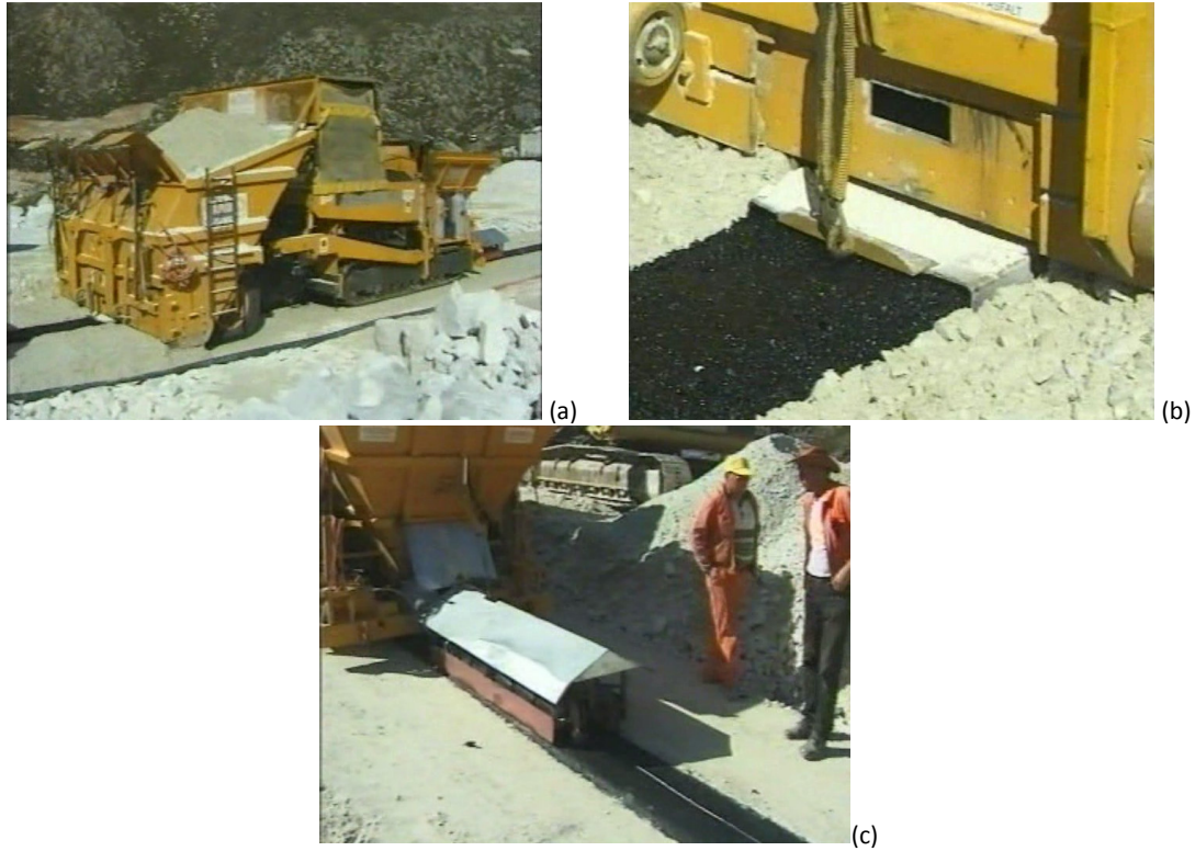
Figura 2.17 – Execução da cortina e das camadas de transição com o Paver : (a) Paver em funcionamento; (b) pormenor da aplicação da mistura; (c) pormenor do dispositivo de infravermelhos.
