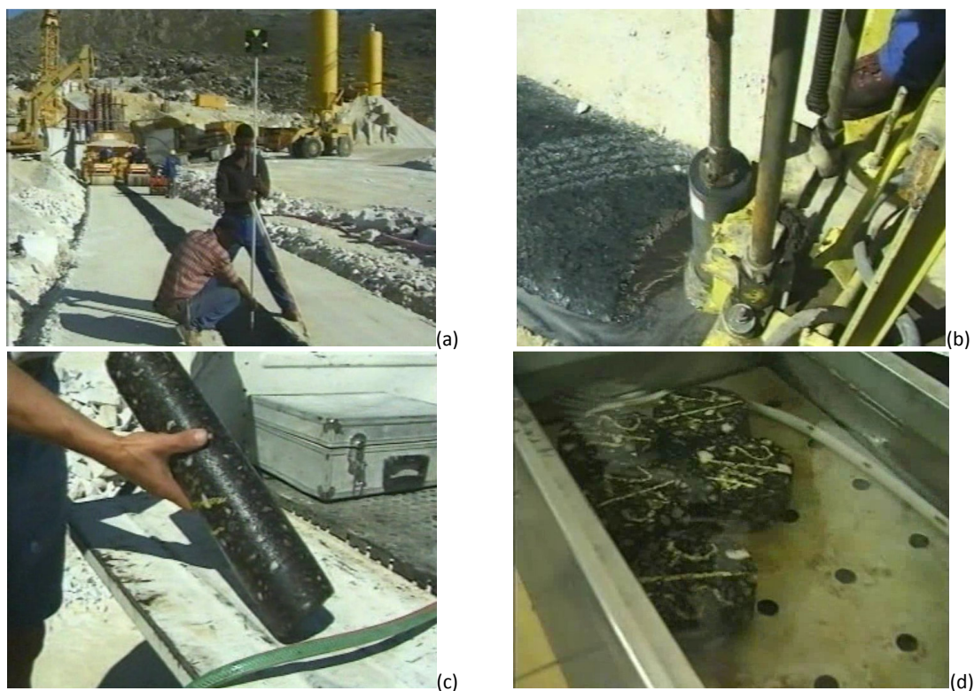
Figura 2.19 – Controlo de qualidade da cortina: (a) alinhamento e espessura das camadas; (b) extracção de um provete; (c) provete; (d) ensaios para determinação da porosidade e do peso volúmico.
