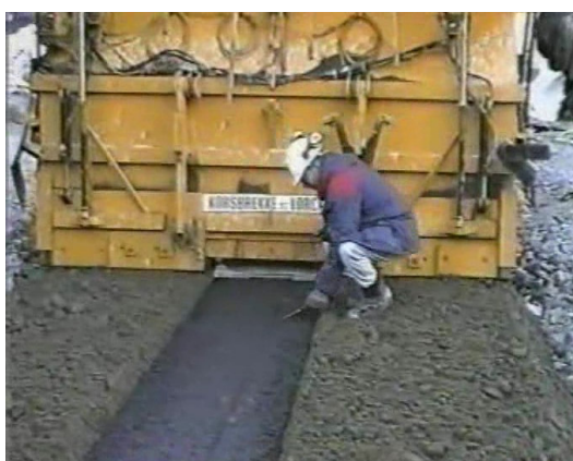
Figura 2.20 – Medição da temperatura do betão betuminoso aplicado.
