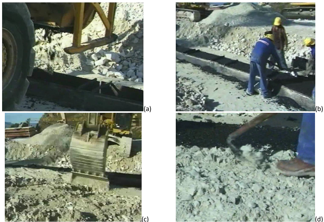
Figura 2.16 – Construção da primeira camada de betão betuminoso: (a) colocação do material nos moldes; (b) compactação manual do betão betuminoso; (c) colocação do material de transição; (d) arrumação manual dos materiais.
