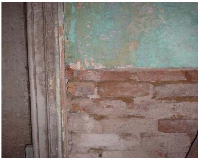
Figura 6.17 – Paredes em tijolos de barro
