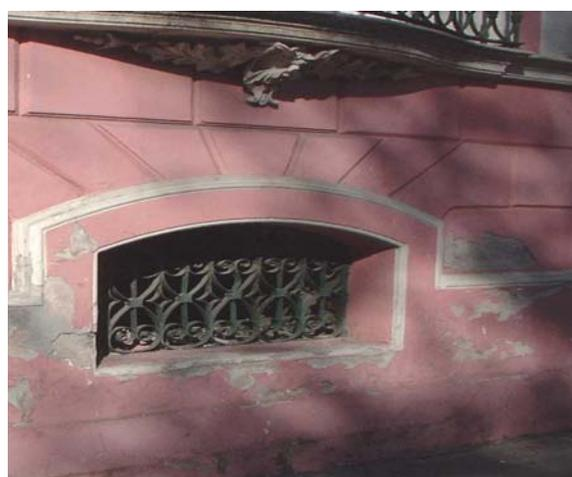
Figuras 6.14 – Detalhe da caixa de ventilação
