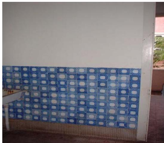
Figuras 6.20 e 6.21 – Revestimento em escaiola e azulejos (respectivamente)
