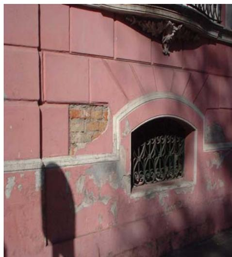
Figuras 5.4 e 5.5 – Umidade ascensional e de infiltrações, descolamento em placas e eflorescências
