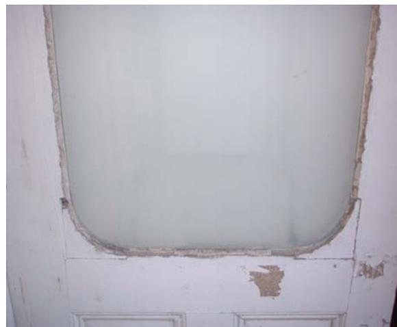
Figuras 6.26 e 6.27 – Perda da massa de fixação dos vidros e apodrecimento dos caixilhos
