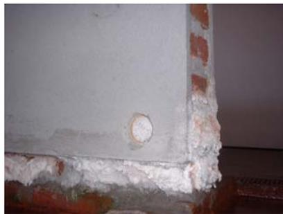
Figura 8.21: Reboco 03 CHB - Formação eflorescente no local donde foi extraída amostra do reboco
