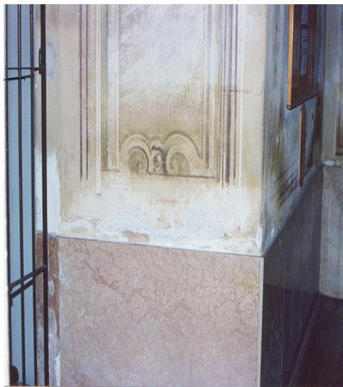
Figuras 5.6 e 5.7 – Encobrimentos das eflorescências por revestimento em madeira e pedra
