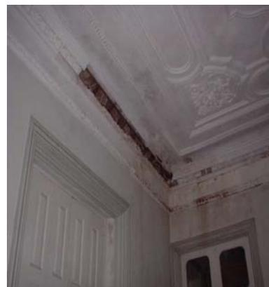
Figuras 6.36, 6.37 e 6.38 – Infiltrações nos tetos e paredes
