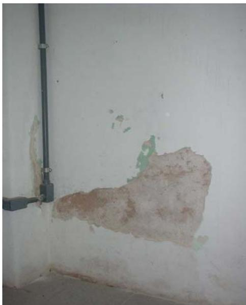
Figuras 5.8 e 5.9 – Agravamento das eflorescências pelo uso inadequado de materiais na construção e/ou recuperação
