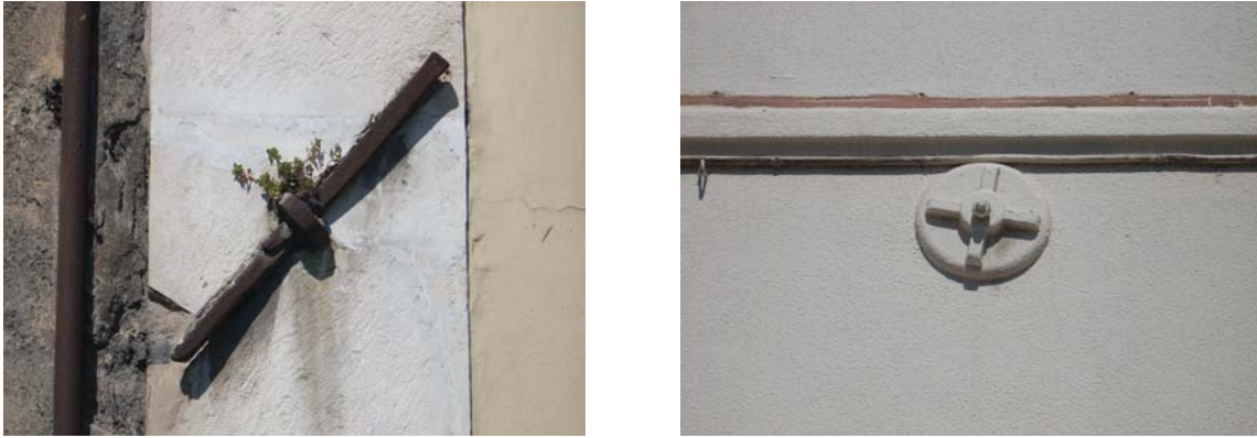
Figura 2.5 – Exemplos de peças metálicas de ligação
