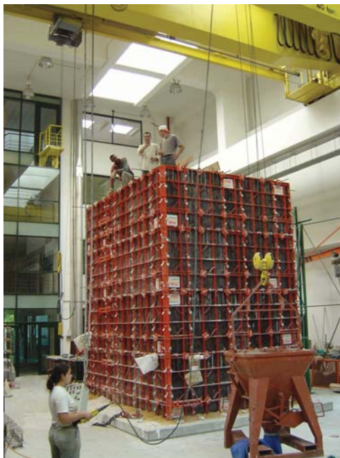
Figura 3.13 – Vista da cofragem utilizada na construção das paredes resistentes colocada sobre a laje reutilizável em betão armado
