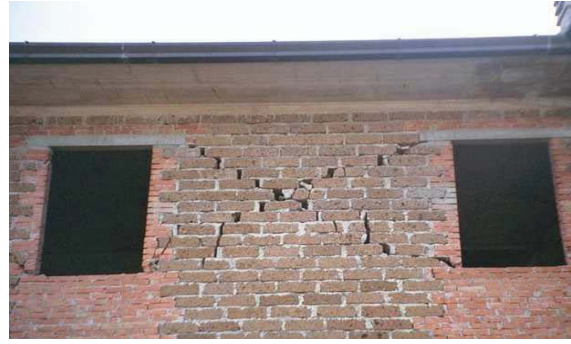
b) Rotura por tracção diagonal
