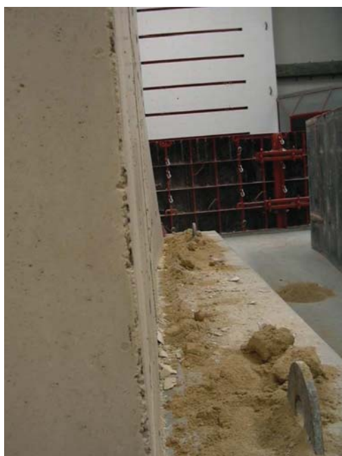
c) Aumento local da espessura da parede
