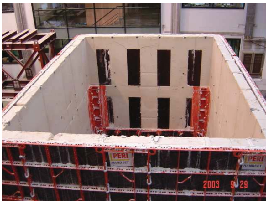
Figura 3.14 – Remoção da cofragem do Modelo 3
