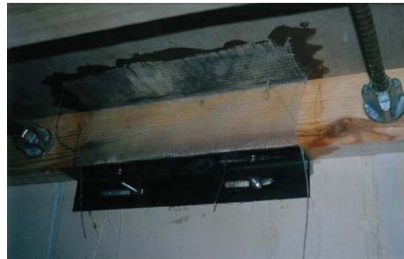
b) Aspecto da ligação na face inferior do pavimento
