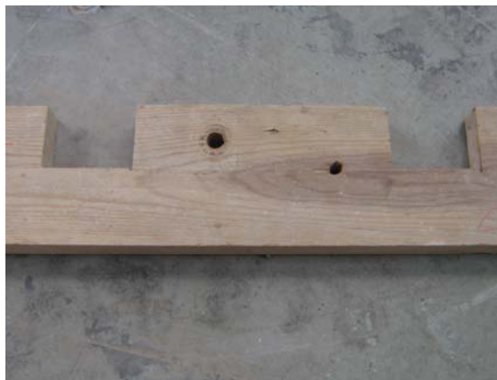
Figura 3.15 – Peças denteadas colocadas ao longo da face interior das empenas onde assentam as vigas do pavimento
