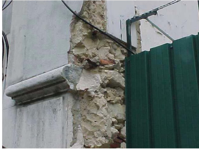
Figura 2.14 – Pormenor de um cumhal das paredes resistentes de alvenaria
