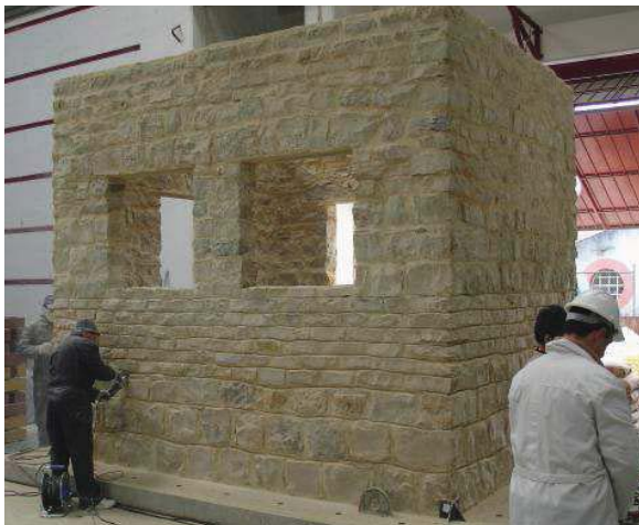
a) Preparação da superfície da parede
