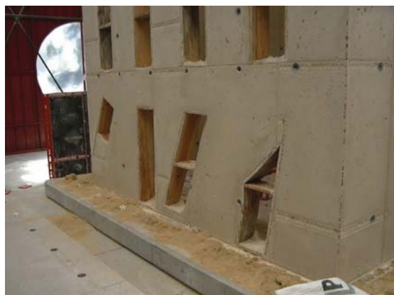
a) Janelas deformadas e/ou deslocadas
