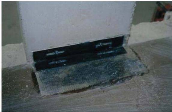
a) Aspecto da ligação na face superior do pavimento
