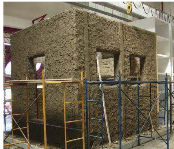
d) Execução do reboco armado
