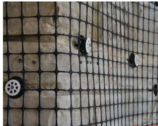
b) Pormenor da colocação da rede RichterGard® 20 com os espaçadores
