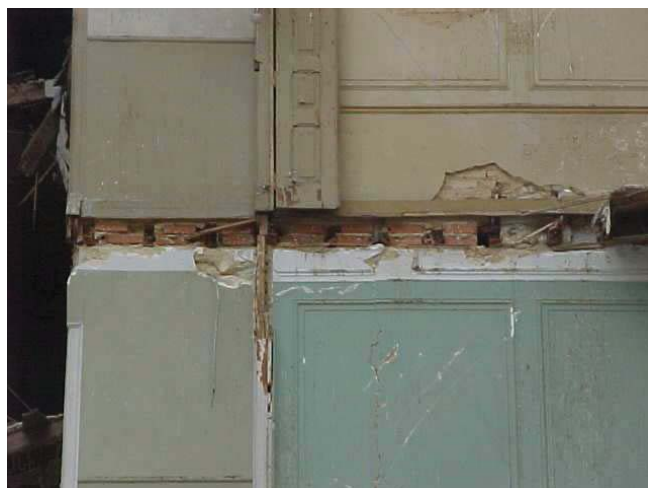
Figura 2.15 – Pormenor de uma parede evidenciando a ligação do pavimento
