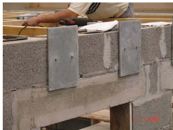
b) Ligação das vigas às paredes
