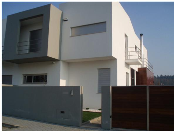
Figs. 1 e 2 – Revestimentos ETICS em moradias, com acabamento do tipo reboco roscone pintado e, num caso, placas de pedra coladas.
