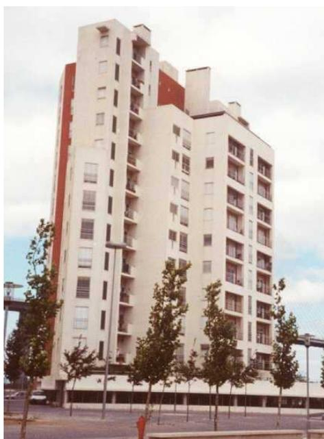
Fig. 3 – Edifício multipisos em Lisboa revestido com ETICS
