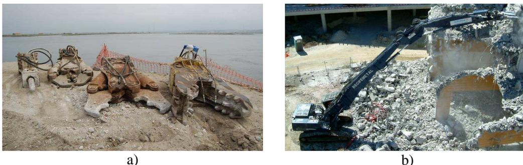
Figura 4 – Equipamentos e acessórios de demolição: a) martelo de percussão, tesouras de demolição de betão, demolidor/pulverizador; b) giratória com lança de 25 metros, equipada com tesoura de corte de betão
