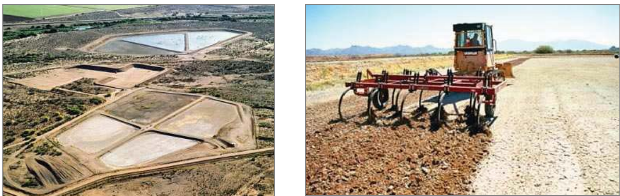
Figura 2.14 – Vista aérea dos sistemas de recarga relativos aos Projectos de Avra Valley e Lower Santa Cruz. Operações de manutenção de raspagem do fundo realizadas numa das bacias (CAP, 2007).
