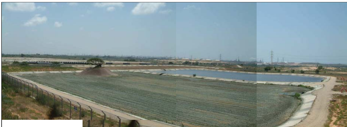
Figura 2.17 - Pormenor de duas bacias de infiltração no Complexo de recarga artificial de Shafdan durante a visita de estudo a Israel (em Maio/2006).
