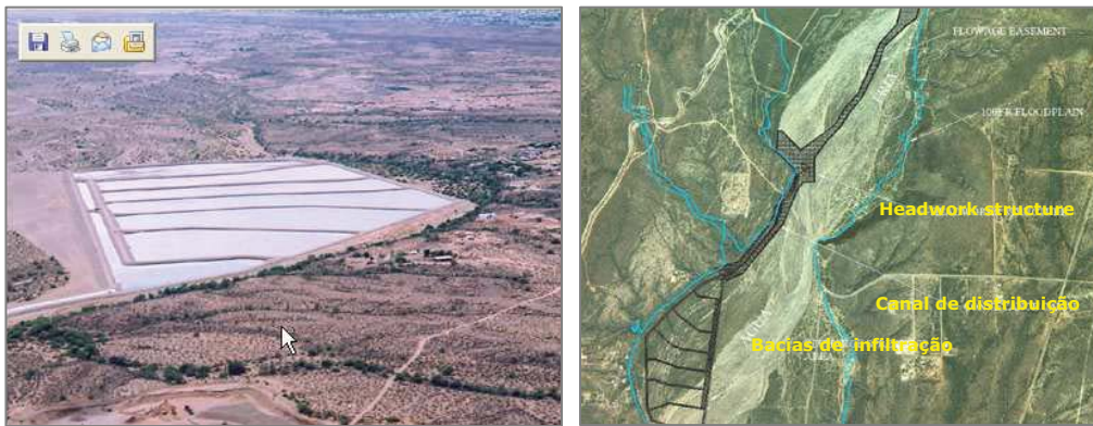
Figura 2.13 – Vista aérea das instalações de recarga artificial do Projecto Água Fria, no Arizona (CAP, 2007).
