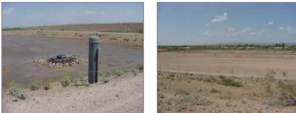
Figura A.3 – Bacias de infiltração do Projecto de recarga de Hieroglyphic Mountains durante os ciclos de secagem e enchimento; pormenor de um piezómetro que contém uma sonda no interior para registo do nível de água (CAP, 2007).
