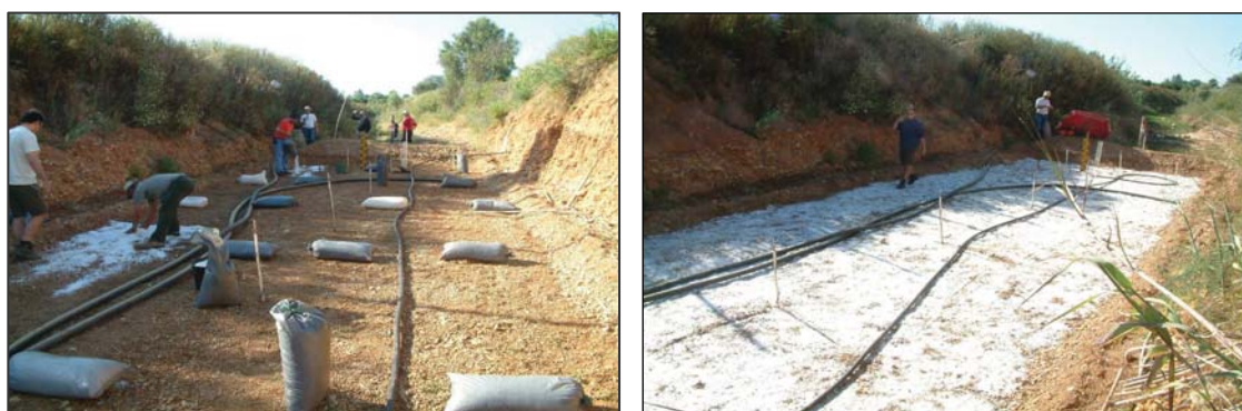
Figura 5.35 – Colocação do traçador (NaCl) na bacia de infiltração de Carreiros
