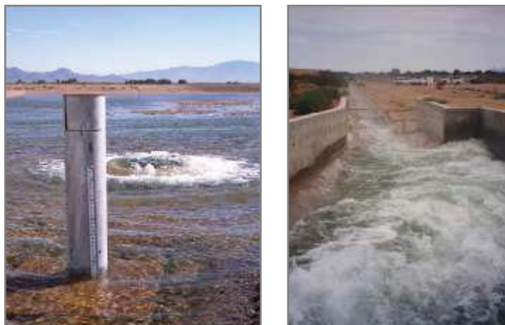
Figura A.2 – Bacia de infiltração do Projecto de recarga de Lower Santa Cruz e canal de irrigação; pormenor de um piezómetro para registo do nível de água. Arizona (CAP, 2007).
