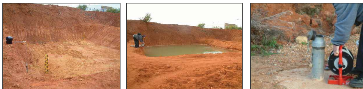
Figura 5.5 – Bacia de infiltração na 2ª camada litológica, antes e após o seu enchimento. Pormenor do piezómetro LNEC4 durante o registo manual da profundidade do nível da água
