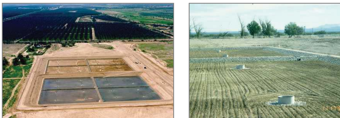
Figura A.4 – Bacias de infiltração do Projecto de Pima Mine Road (lado esquerdo em operações de manutenção secagem e recarga e lado direito após a raspagem do fundo) (CAP, 2007).
