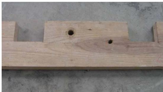
Figura 2-5 – Vigas denteadas colocadas ao longo da face interior das empenas onde assentam os barros do pavimento [Candeias, 2008]
