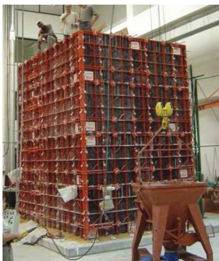
Figura 2-4 – Vista da cofragem utilizada na construção das paredes resistentes colocada sobre a laje reutilizável em betão armado [Candeias, 2008]
