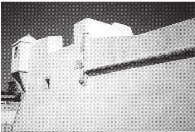
Fig. 15 – Forte revestido com argamassa bastarda fraca
