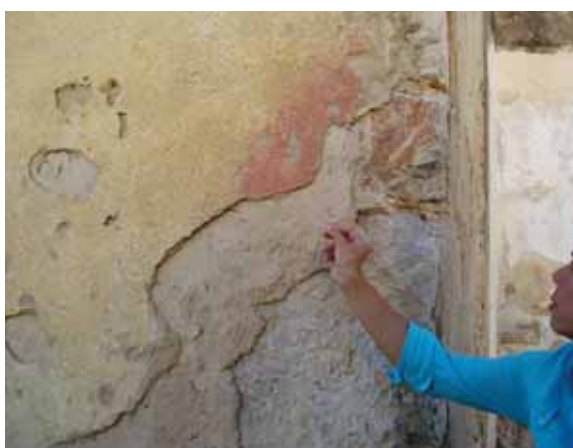
c) Revestimento de Hospital em Lisboa (séc. XIX)
