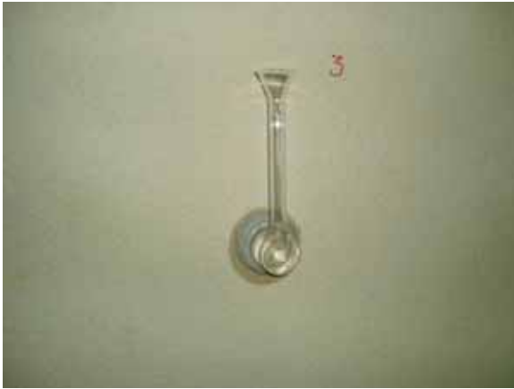
Fig. 29 – Aplicação de tubos de Karsten em revestimento antigo
