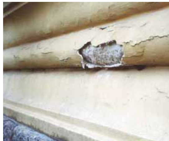
Fig. 6 – Tinta polimérica dificultando a evaporação da água e conduzindo à degradação do reboco antigo
