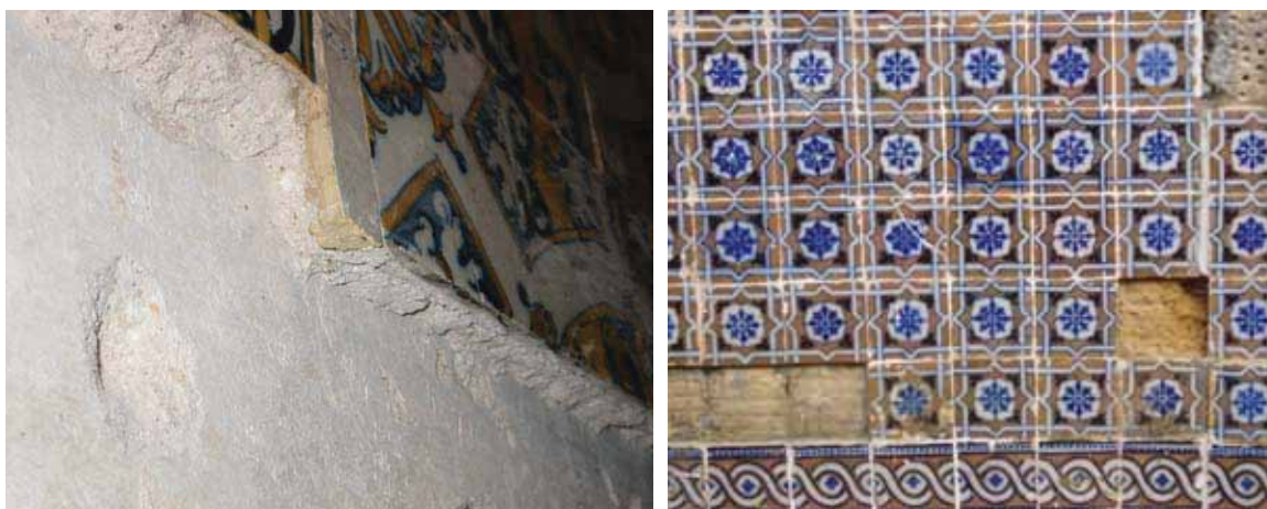
Fig. 46 – Revestimentos antigos de azulejos assentes com argamassas de cal a) séc. XVII, em Elvas e b) séc. XIX, em Ovar
