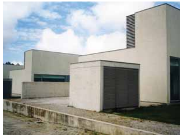
Fig. 18 – Revestimentos modernos com base em cimento a) monocamada e b) ETICS
