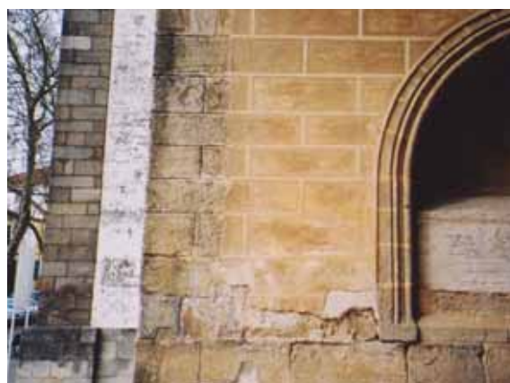
b) Reboco exterior da Sé de Évora (séc. XVII)
