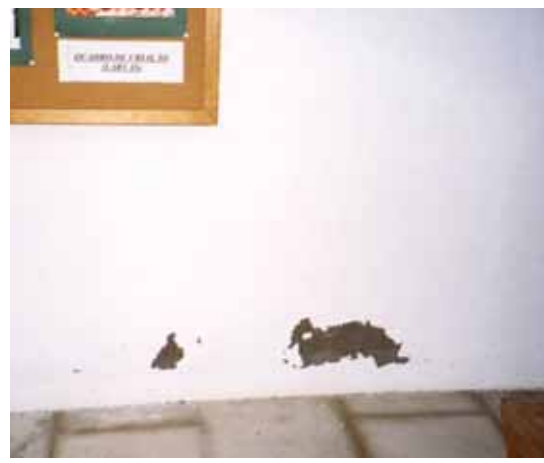
Fig. 4 – Reboco de cimento contribuindo para a retenção de água numa parede antiga
