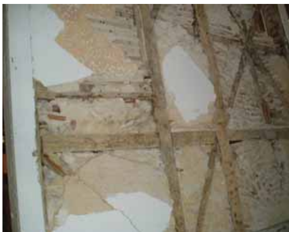
Fig. 11 – Parede Pombalina com argamassa de cal aérea
