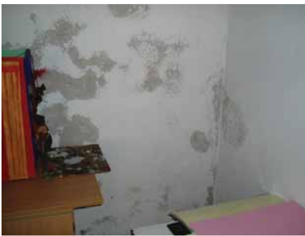
Fig. 4 – Reboco de cimento contribuindo para a retenção de água numa parede antiga
