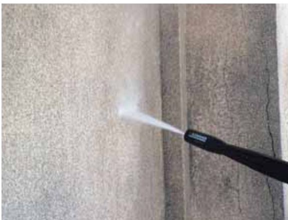
Fig. 37 – Limpeza com jacto de água com baixa pressão
