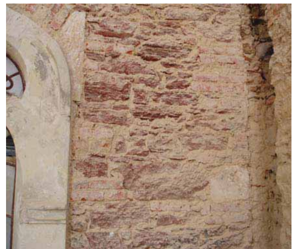
Fig. 47 – Vários tipos de suportes: cantaria, alvenaria irregular de pedra e tijolo, alvenaria irregular de pedra com juntas de terra, adobe
