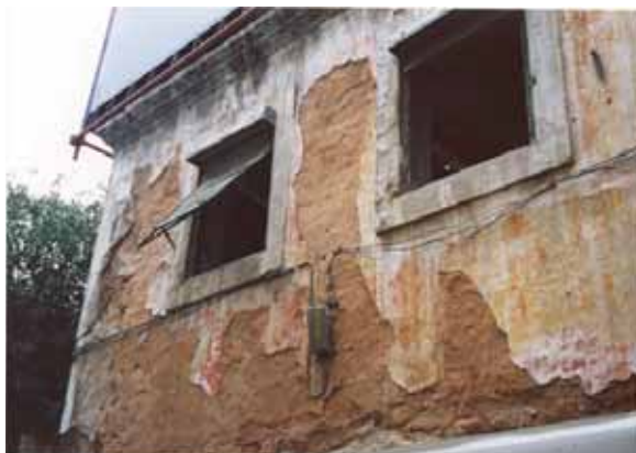
Fig. 9 – Construção em terra
