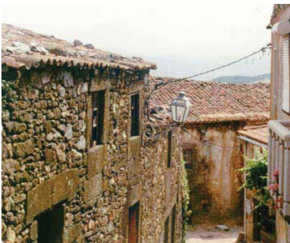
Fig. 47 – Vários tipos de suportes: cantaria, alvenaria irregular de pedra e tijolo, alvenaria irregular de pedra com juntas de terra, adobe
