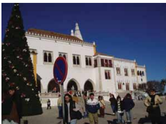
Fig. 39 – Palácio da Vila, em Sintra, após restauro do revestimento de fachada, com consolidação (década de 1990).
