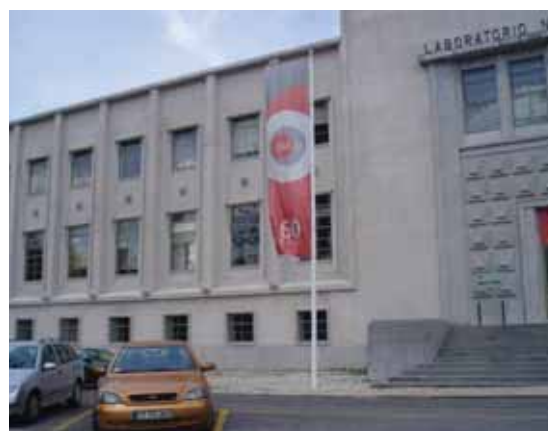
Fig. 40 – LNEC, Edifício Arantes e Oliveira, após restauro do revestimento de fachada, com consolidação (2006).
