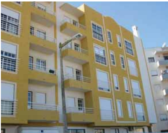
Fig. 18 – Revestimentos modernos com base em cimento a) monocamada e b) ETICS
