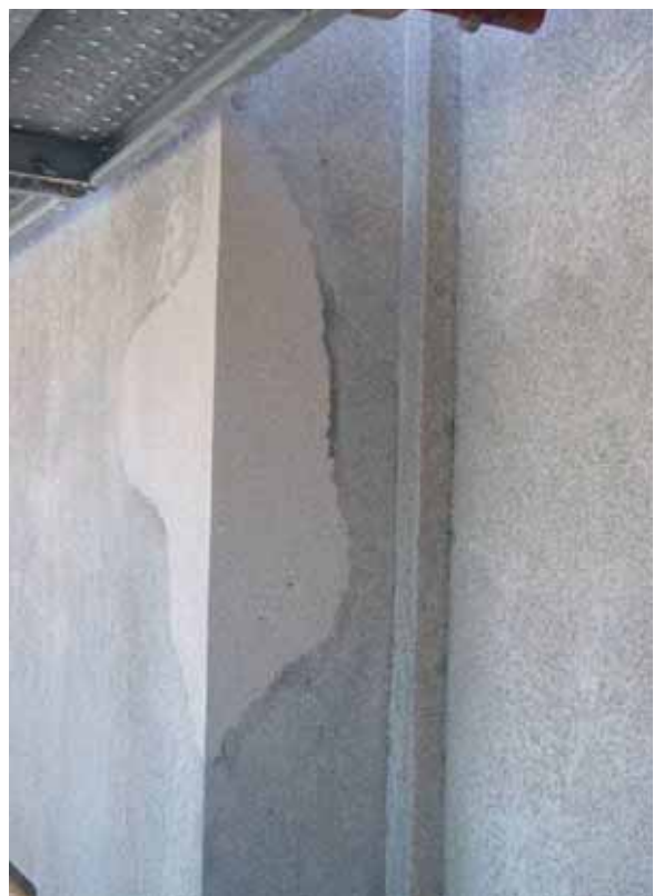
Fig. 38 – Colmatação de lacuna com material semelhante
