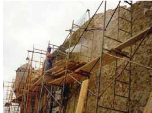
Fig. 3 – Forte na zona de Lisboa: revestimento antigo (séc. XVII) e extracção
