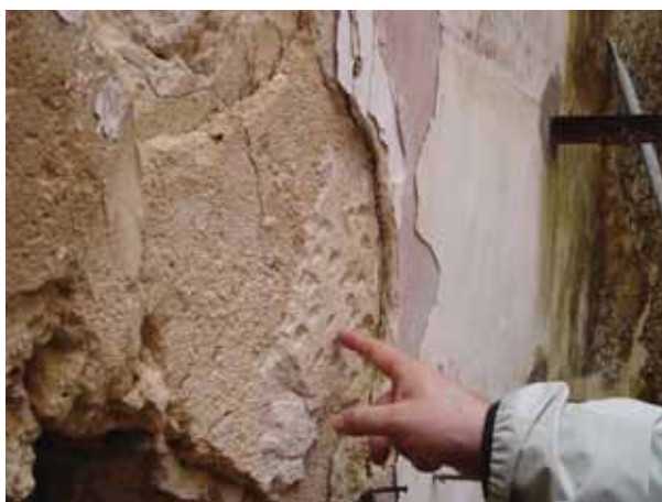
Fig. 20 – Camada intermédia picada para aderência da camada seguinte de reboco
