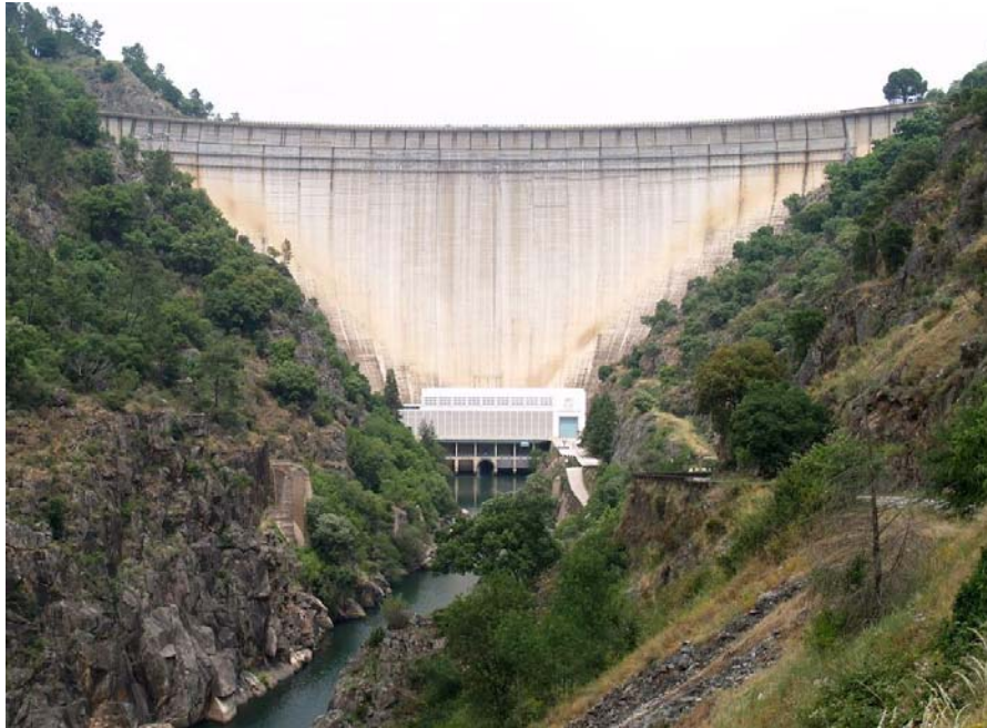
Fig. 1 Vista geral (de jusante) da Barragem do Cabril
