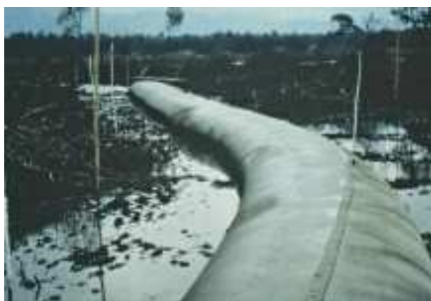
Figura 18 – Geotubos na fase de preenchimento ( www.igsbrasil.org.br , consultado em 2.04.2007).
