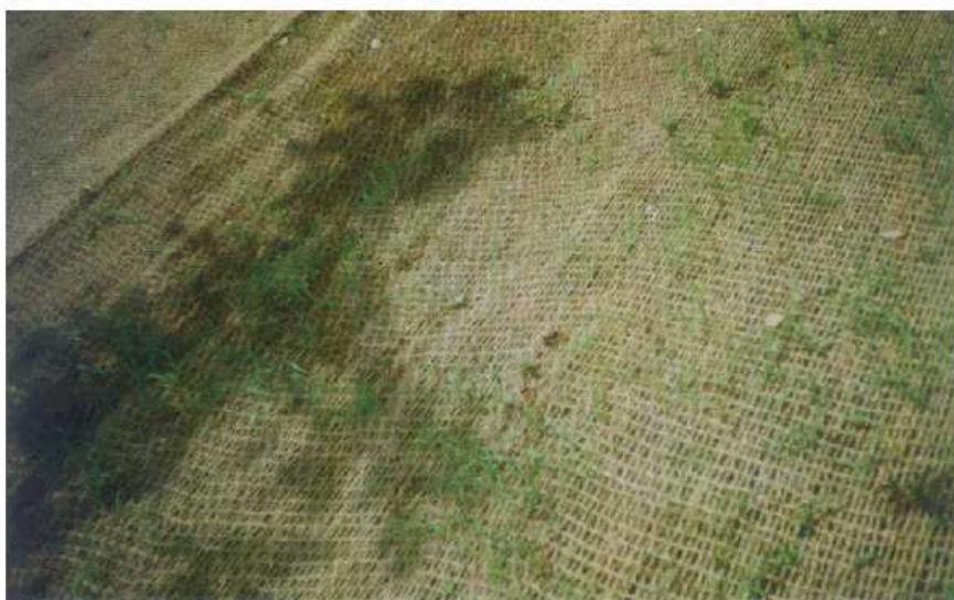
Figura 17 – Uma das vertentes protegidas com o geotêxtil de fibras de coco, após um mês de colocação (Lecka, 2004).
