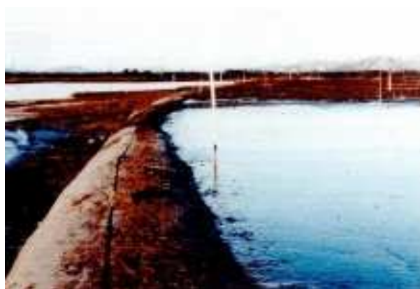
Figura 19 – Geotubos já preenchidos, contendo o aterro ( www.igsbrasil.org.br , consultado em 2.04.2007).
