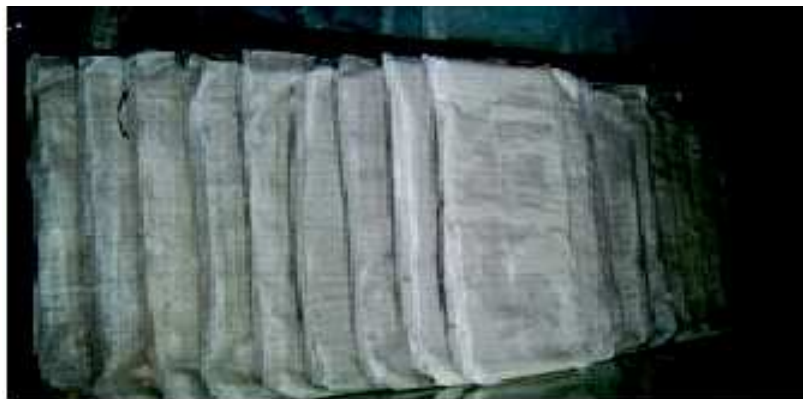
Figura 4 – Dique constituído por geossacos (Gang et al., 2006).
