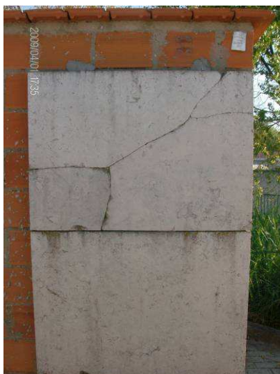
Fig. 4 - Fendilhação de placa de pedra aplicada com gatos
