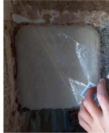
Fig. 6: Aplicação de uma cobertura semi-permeável sobre a compressa para proporcionar uma secagem mais lenta
