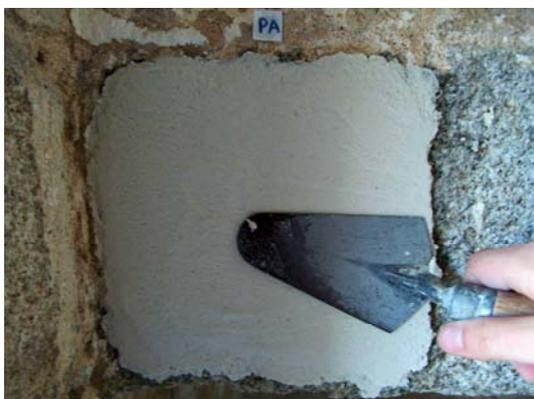
Fig. 5: Aplicação manual de uma compressa de dessalinização
