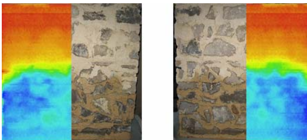
Fig. 13 – Aspecto da relação entre as observações visuais e termográficas
