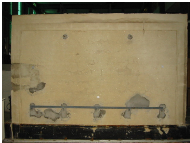
Fig. 3 – Aspecto de uma parede de alvenaria de blocos de betão de argila expandida [5]
