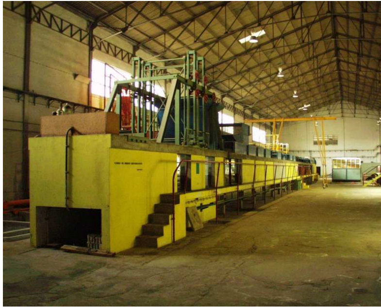
Figura 15 – Vista geral do COI1.
