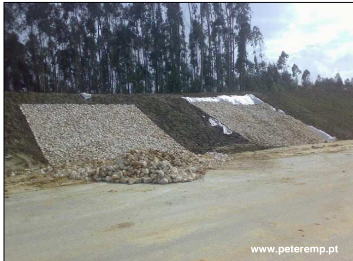
Figura 3.13 – Fotografia de máscaras drenantes (Auto-Estrada A17).
