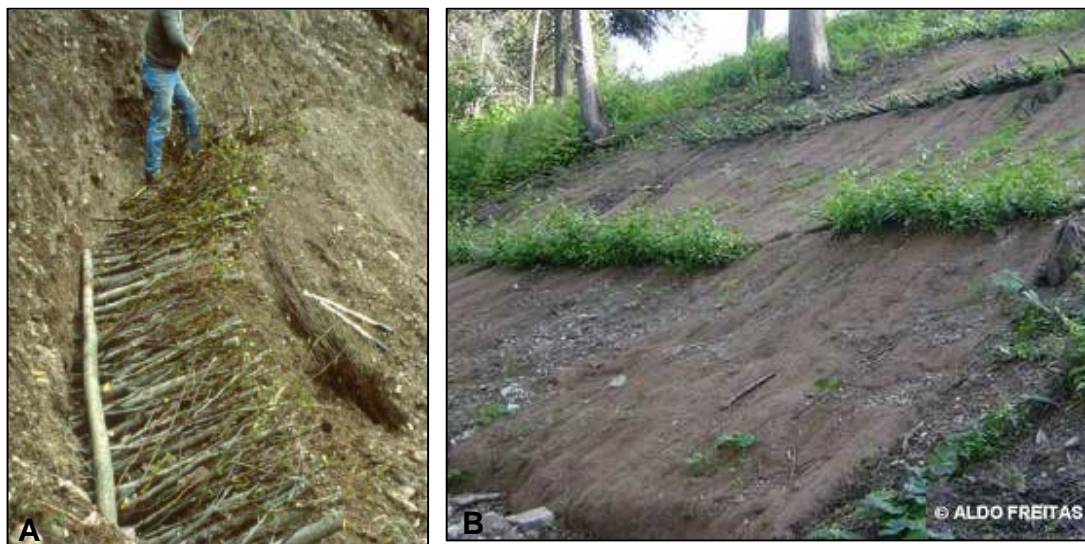
Figura 4.14 – Fotografias da técnica faixa de vegetação. A – Fase de construção. B – Aspecto final.
