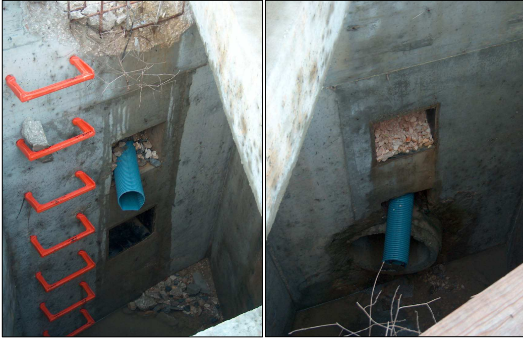
Figura 5.22 – Pormenor das obras de drenagem sub-superficiais
