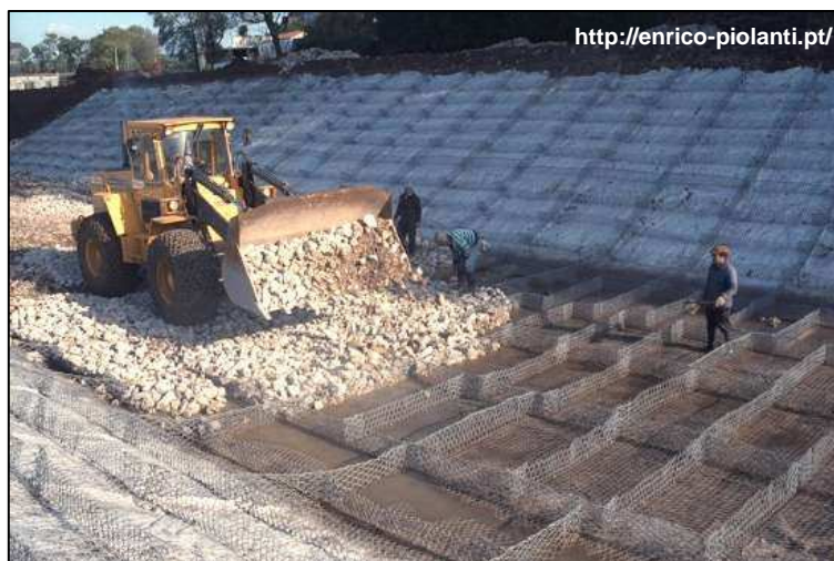
Figura 3.14 – Estruturas do tipo gabião-manta (rio Jamor).
