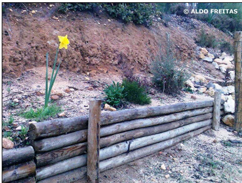
Figura 4.8 – Fotografia de uma obra da técnica do tipo paliçada viva.
