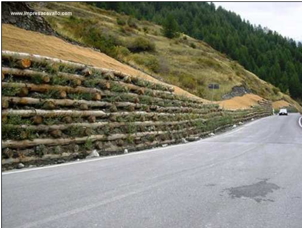
Figura 4.19 – Fotografia de uma obra do tipo muro de suporte vivo realizado ao longo de um talude numa estrada em Itália.
