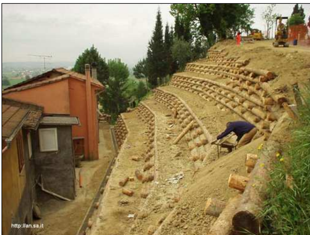
Figura 4.18 – Fotografia de várias obras do tipo muro de suporte vivo realizado ao longo de um talude em Itália.
