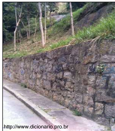
Figura 3.4 – Esquema e fotografia de um muro de suporte do tipo gravidade.
