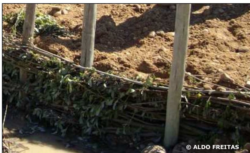
Figura 4.10 – Fotografia da técnica do tipo entrançado vivo.
