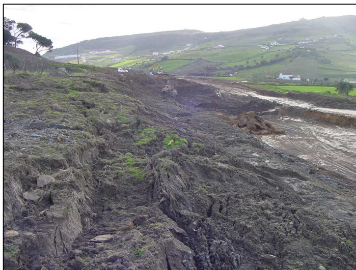
Figura 5.21 – Remoção da zona instabilizada dos depósitos de vertente ao km 7+000.
