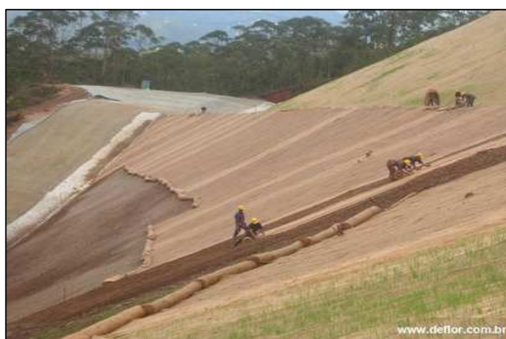
Figura 4.6 – Aplicação de manta orgânica num talude.
