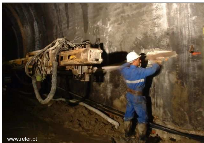
Figura 3.15 – Execução de um dispositivo do tipo dreno horizontal profundo (túnel do Rossio).
