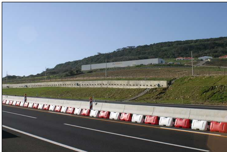
Figura 5.18 – Vista final das obras de estabilização ao km 5+700.
