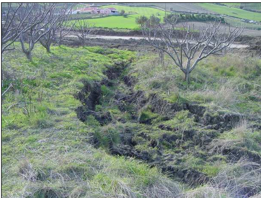
Figura 5.20 – Vista do escorregamento ocorrido ao km 7+000.
