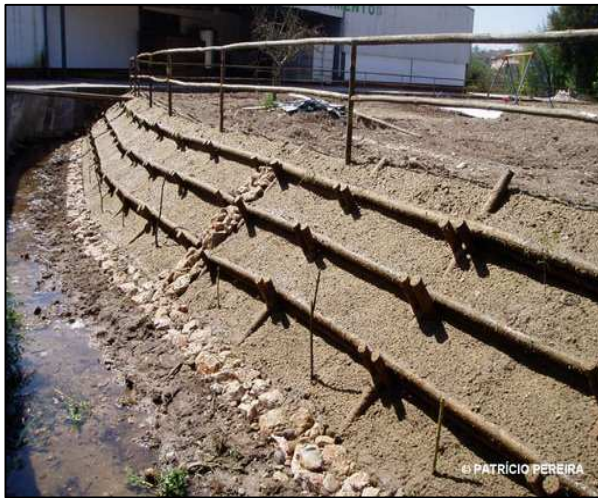
Figura 4.24 – Diferentes fases de construção de uma obra de engenharia natural do tipo grade viva, para contenção de uma encosta numa ribeira.
