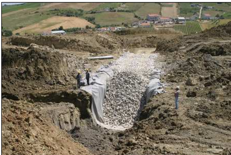
Figura 5.15 – Execução de trincheiras drenantes ao km 5+700.
