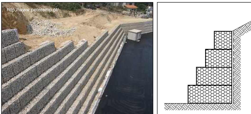
Figura 3.7 – Fotografia e esquema representativo de um muro de gabiões (esquema adaptado de Carvalho et al. , 1991).
