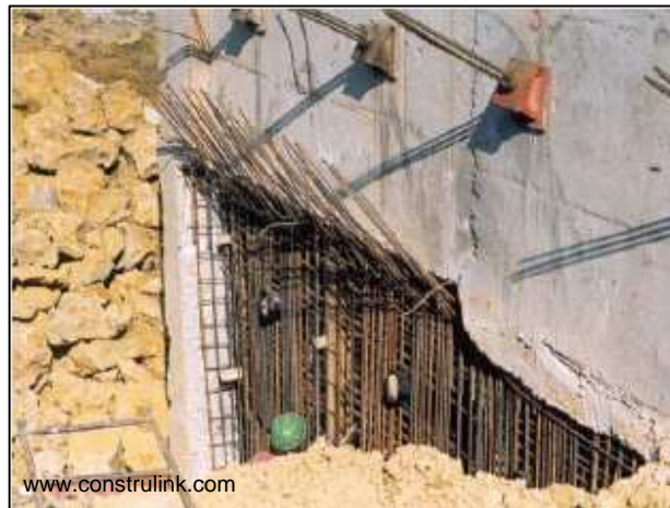
Figura 3.8 – Parede de Contenção do tipo Berlin.
