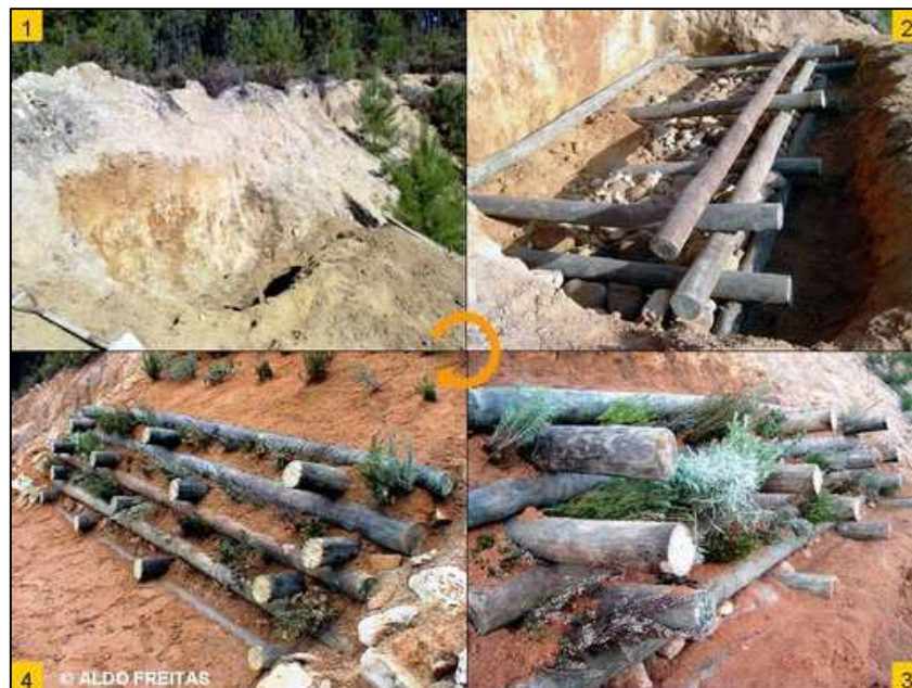
Figura 4.15 – Várias fases de construção de um muro de suporte vivo.
