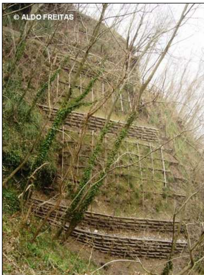
Figura 4.27 – Combinações de obras do tipo grade viva e muro de suporte vivo, em Itália.
