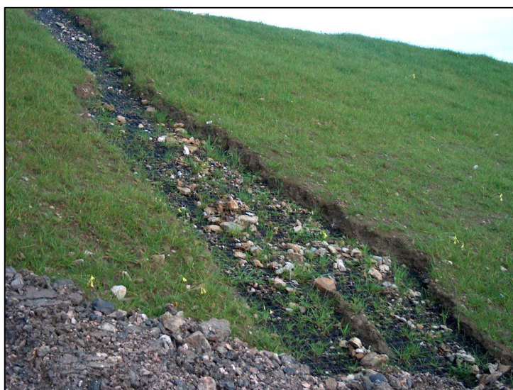
Figura 5.23 – Geogrelha aplicada no talude ao km 7+000.
