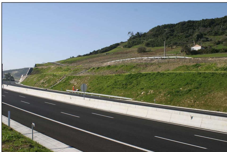
Figura 5.9 – Aspecto final da obra ao km 5+300.
