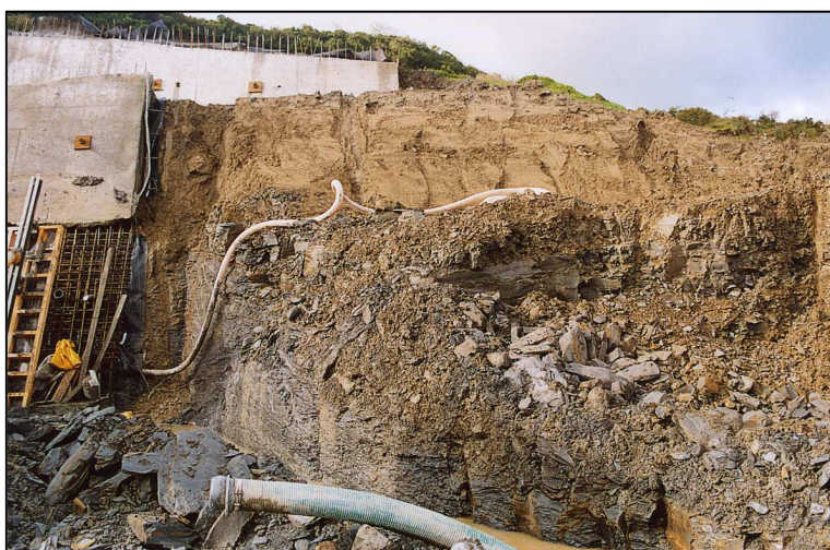
Figura 5.6 – Vista do final da parede ancorada (M3).
