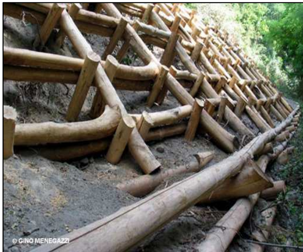
Figura 4.25 – Construção de uma grade viva sobre muro de suporte vivo, em Itália.
