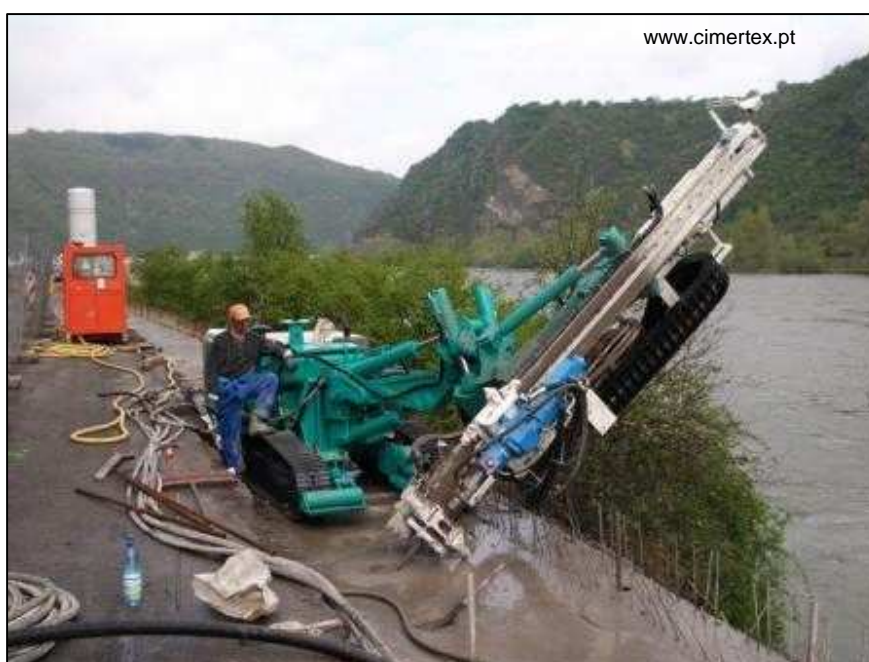
Figura 3.10 – Execução de pregagens.
