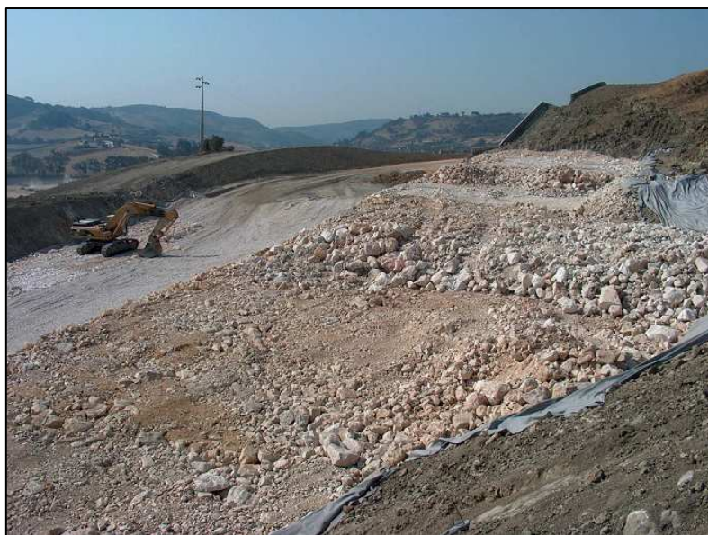
Figura 5.8 – Substituição da zona instabilizada por materiais de enrocamento.
