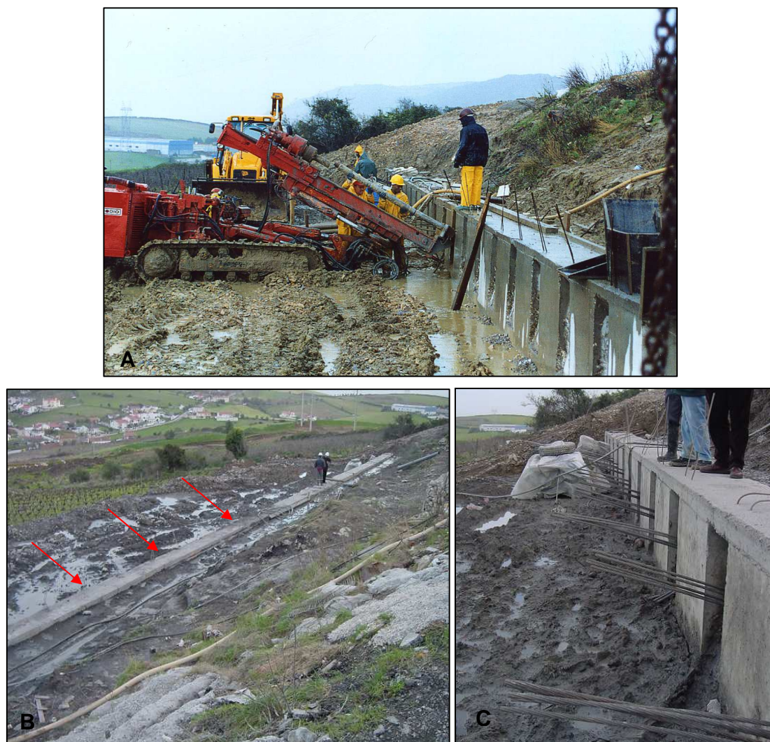
Figura 5.13 – A – Construção da cortina de microestacas ancorada. B – Vista geral da cortina. C – Pormenor da cortina de microestacas ancorada.
