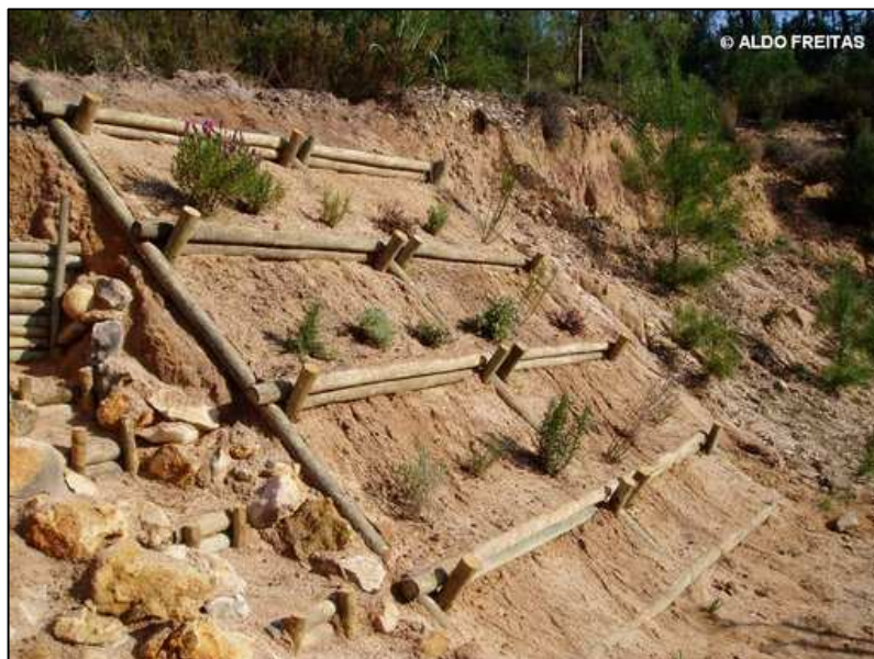
Figura 4.23 – Fotografia de uma construção da técnica grade viva.
