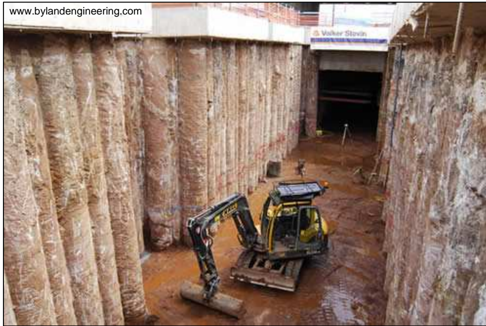
Figura 3.11 – Contenção do tipo cortina de estacas.
