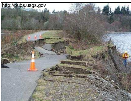
Figura 2.7 – Fotografia e esquema de um movimento do tipo expansão lateral de blocos (esquema adaptado de Mirarco, 2000).
