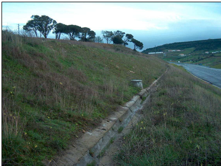
Figura 5.24 – Vista final da obra ao km 7+000.
