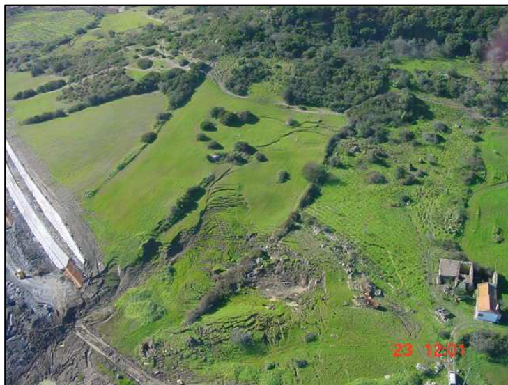
Figura 5.4 – Zona instabilizada ao km 5+300.
