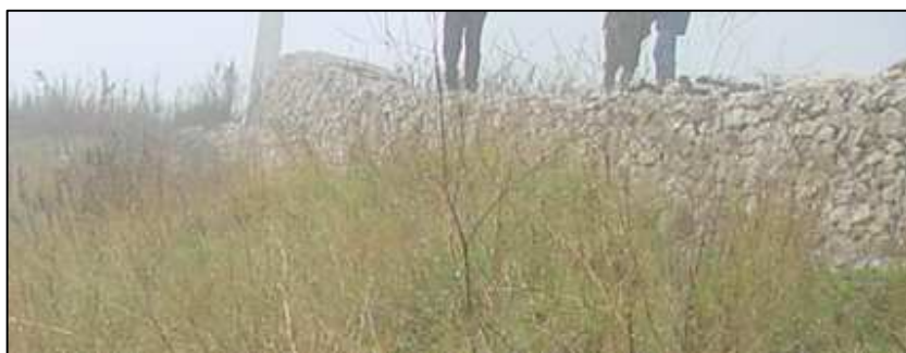
Figura 5.10 – Vista de um dos muros de gabões colocados junto à unidade fabril ao km 5+700.
