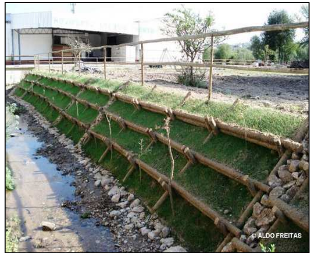
Figura 4.24 – Diferentes fases de construção de uma obra de engenharia natural do tipo grade viva, para contenção de uma encosta numa ribeira.
