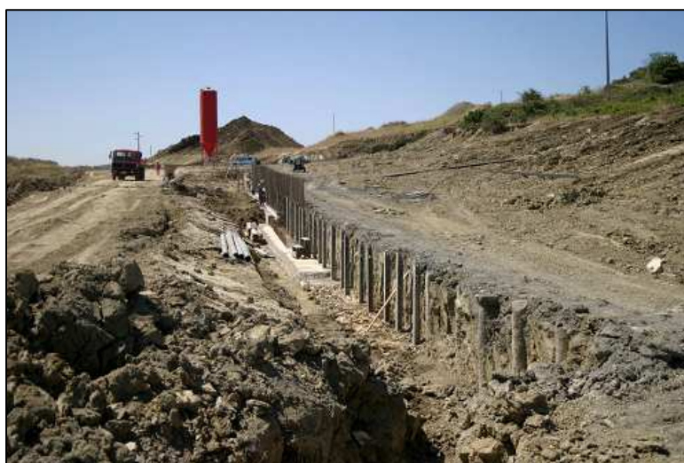
Figura 5.16 – Construção da segunda cortina de microestacas.
