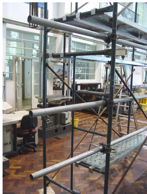
Figura 3.10 – Andaime utilizado para a instalação da instrumentação (2).
