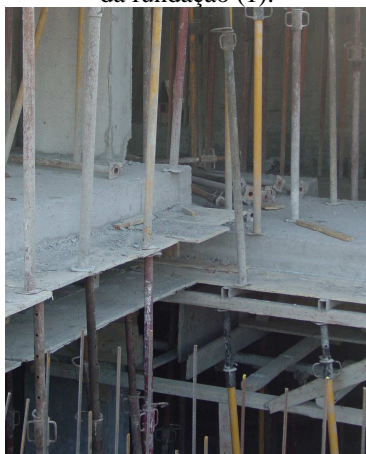
Figura 2.16 – Transmissão de cargas irregular.
