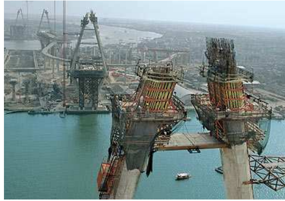
Figura 2.2– Sistema de cofragem móvel
