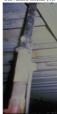
Figura 2.18 – Excentricidades na transmissão de cargas (2).
