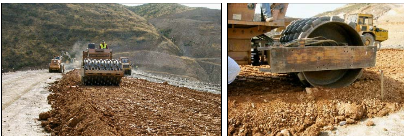
Fig. 3.19 – Cilindro de pés de carneiro (visita técnica à Barragem de Odelouca).
