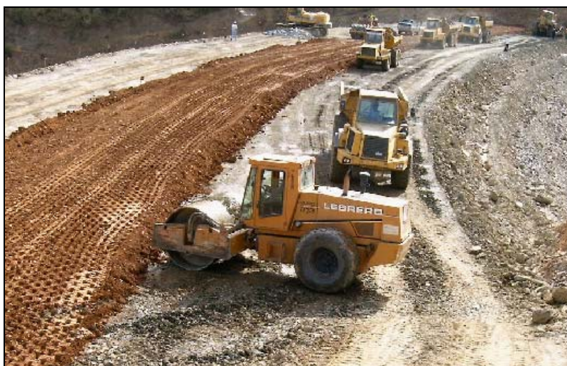
Fig. 3.17 – Cilindro de rasto liso (visita técnica à Barragem de Odelouca).
