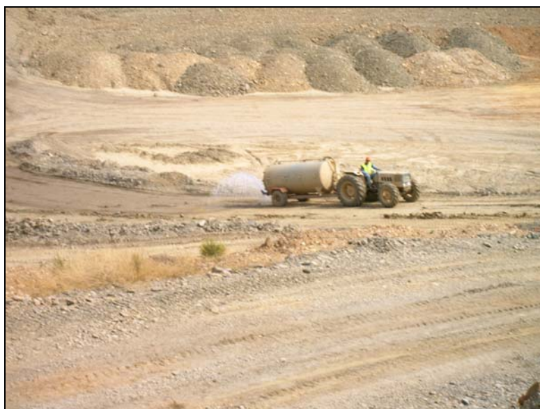
Fig. 3.14 – Camião tanque com barra espalhadora funcionando sobre pressão (visita técnica à Barragem de Odelouca).
