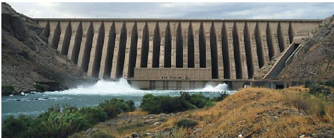
Fig. 3.15 – Barragem de Sefid Rud (Irão) [Wielan, 2002]
