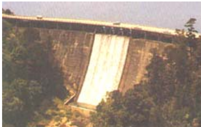
Fig. 1.6 – Barragem de Lower Crystal Springs (EUA) [Cracking Dams]
