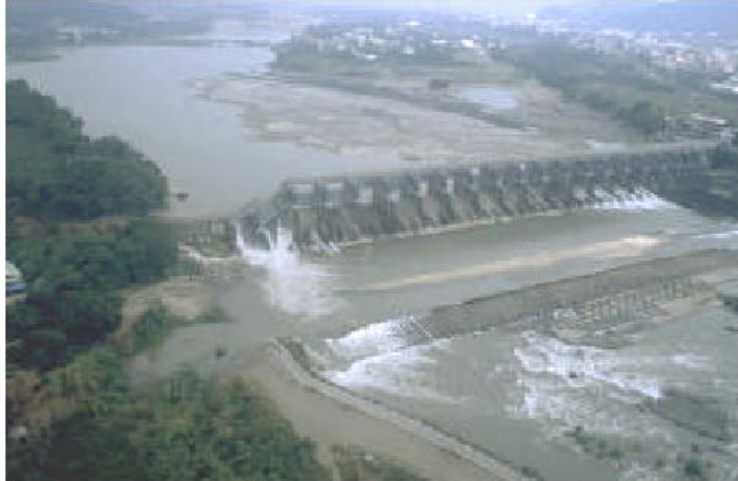
Fig. 3.17 – Barragem de Shih-Kang após o movimento de uma falha localizada na sua fundação durante o sismo Chi-Chi de 1990 [Wielan, 2002]
