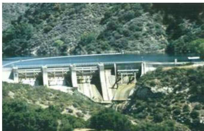
Fig. 3.14 – Barragem de Gibraltar (EUA) [The city of Santa Barbara]
