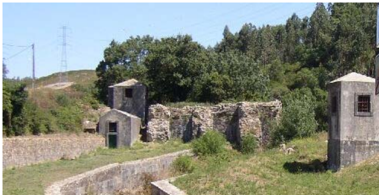
Fig. 1.9 – Ruínas da barragem de Oisipo (Portugal) [Wilke D. Schram]
