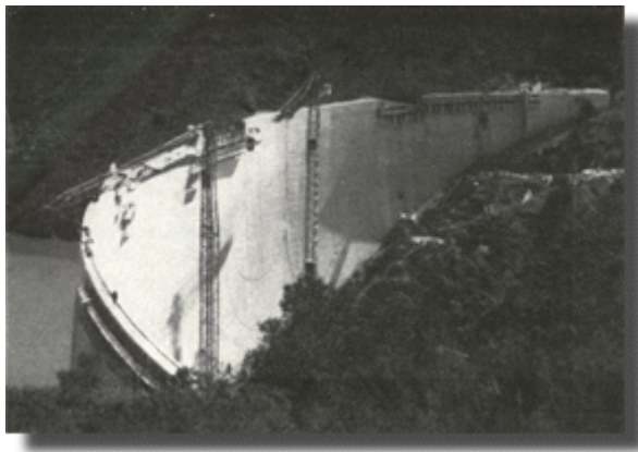
Fig. 3.6 –Barragem de Malpasset (França) [Cracking Dams]
