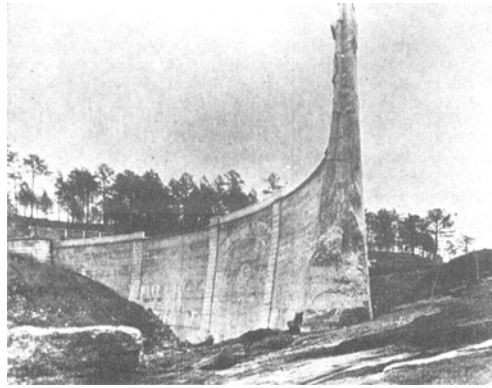
Fig. 3.2 – Barragem de Lake Lanier (EUA), da zona da margem esquerda após a rotura [ICOLD; 1974]
