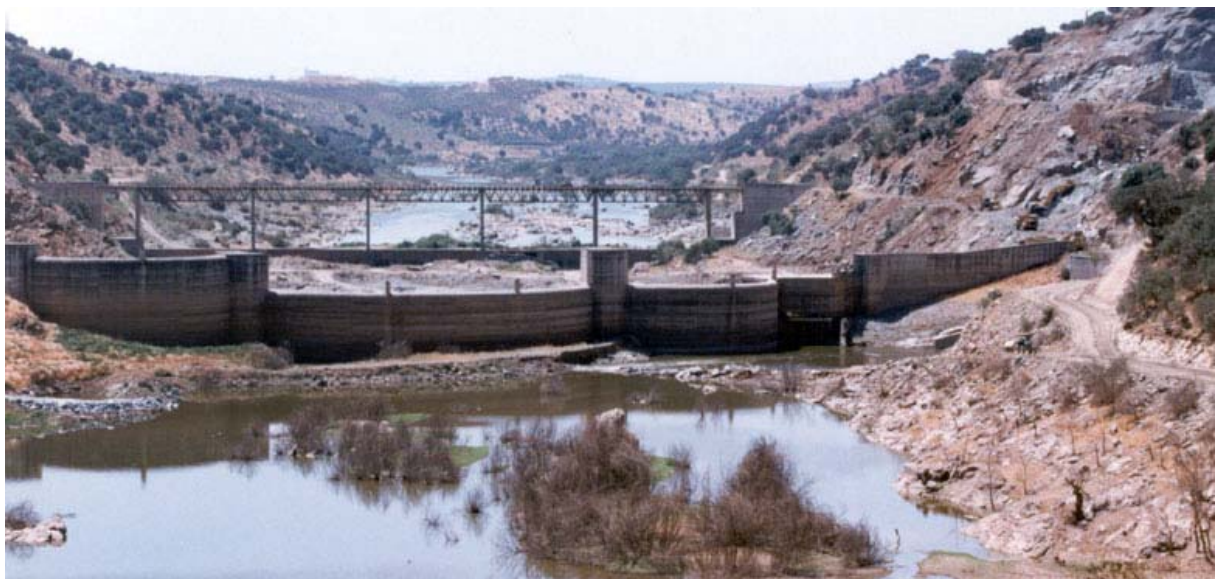
Fig. 5.3 - Vista de montante do local do vale de construção da Barragem de Alqueva
