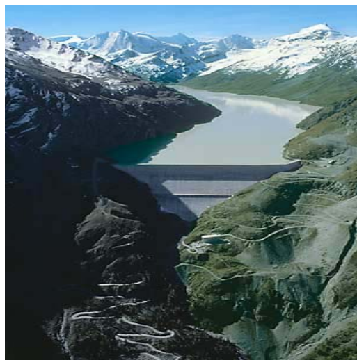
Fig. 1.8 – Barragem gravidade de Grand Dixence (Alpes Suíços) [Encarta MSN]
