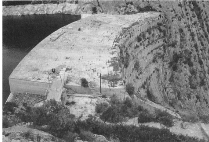
Fig. 1.18 – Barragem em arco de Tibi (Espanha) [Vogel, 2004]
