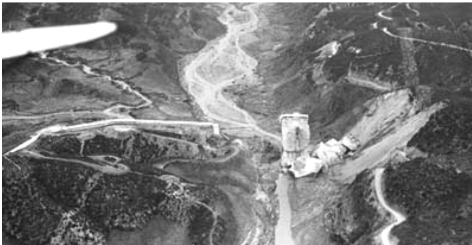
Fig. 3.5 – Barragem de Saint Francis (EUA) após o colapso [Saint Francis Dam Site]
