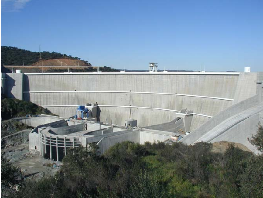
Fig. 5.2 - Vista do paramento de jusante da Barragem de Alqueva
