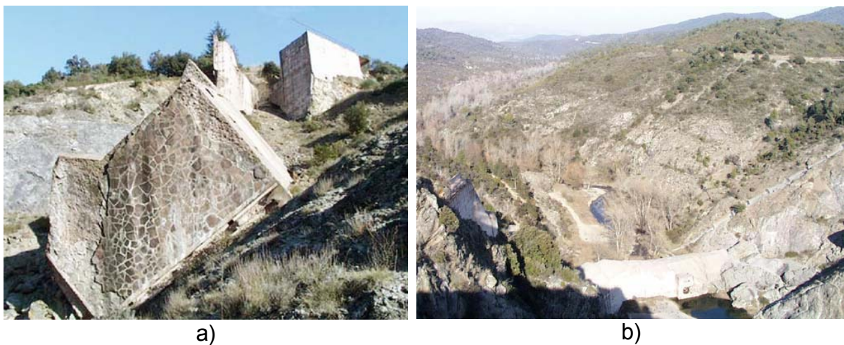
Fig. 3.8 – Rotura da barragem de Malpasset: a) vista do colapso dos blocos da barragem, b) vista do estado actual do local da barragem [Cracking Dams]
