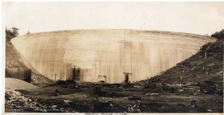
Fig. 1.20 – Barragem de Salmon Creek (EUA)
