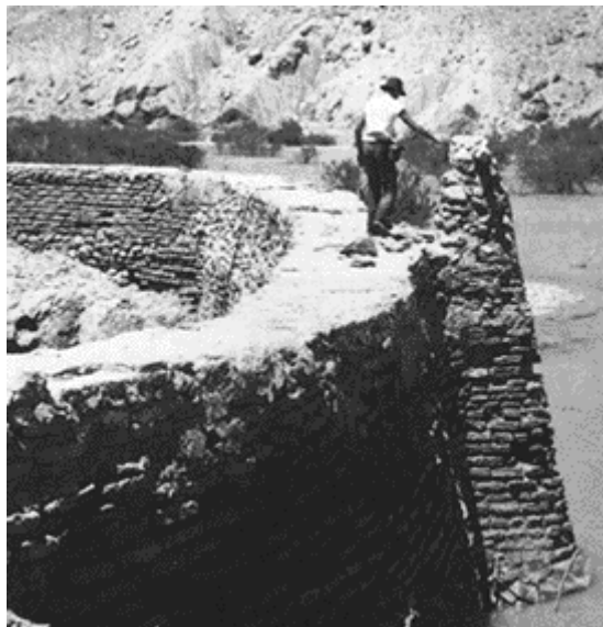
Fig. 1.17 – Barragem em arco de alvenaria de Kurit (Irão) [Schnitter, 1994]
