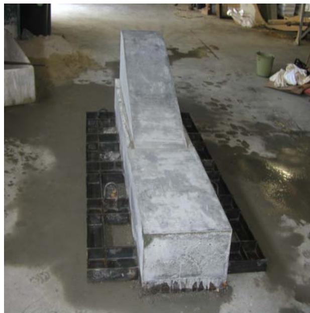
Fig. 6.6 – Vista da fundação continua sobre a base metálica
