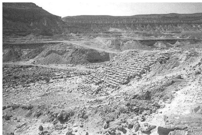
Fig. 1.1 – Ruínas actuais da barragem de Saad El-Kafara, Egito [Vogel, 2004]
