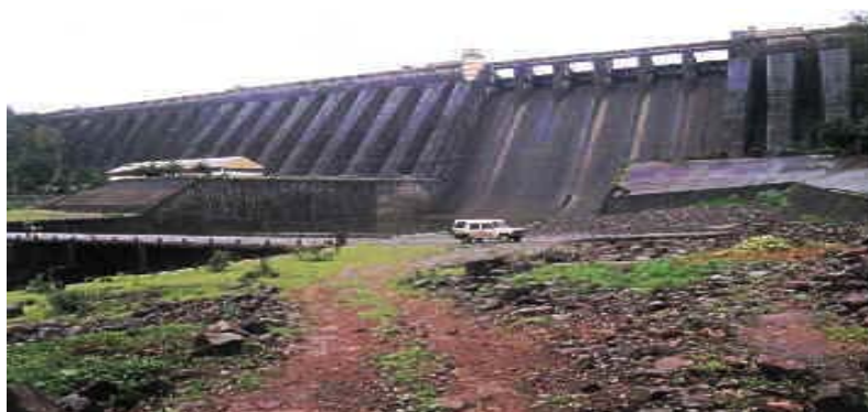
Fig. 4.6 – Barragem de Kyona, Índia
