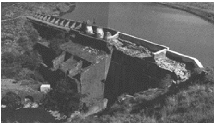
Fig. 1.11 – Barragem de contrafortes de Castellar (Espanha) [Schnitter, 1994]
