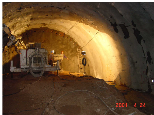
Figura 7.6 - Escavação da meia secção superior
