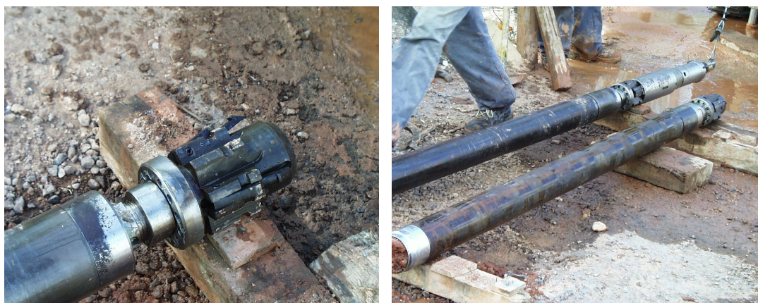
Figura 5.3 - Pormenores do processo de amostragem com recurso a sonda tripla (método de Geobor S)
