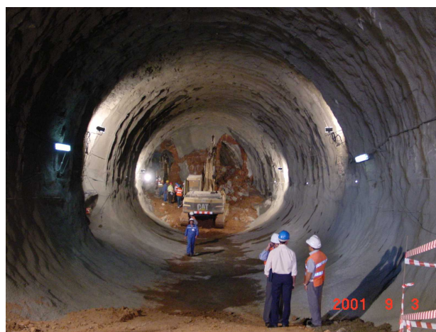
Figura 7.5 - Escavação da meia secção superior junto ao emboquilhamento
