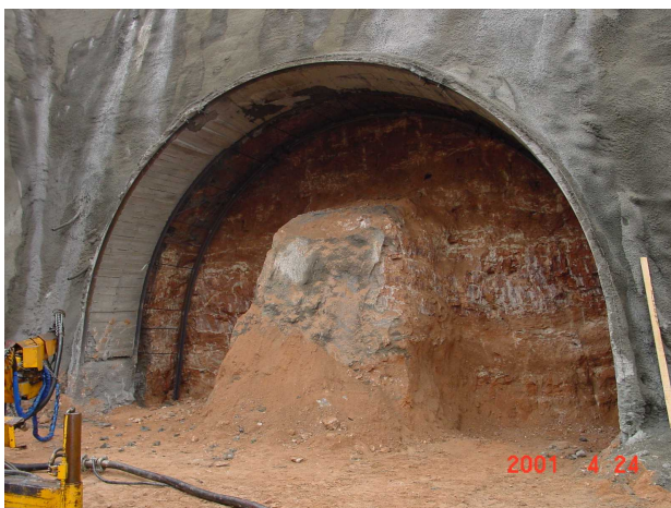
Figura 7.5 - Escavação da meia secção superior junto ao emboquilhamento
