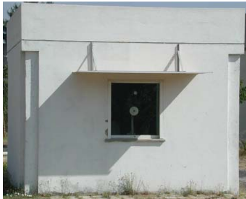
Figura 4.55 – Aspecto da célula sul com vidro duplo incolor e pala horizontal de madeira
