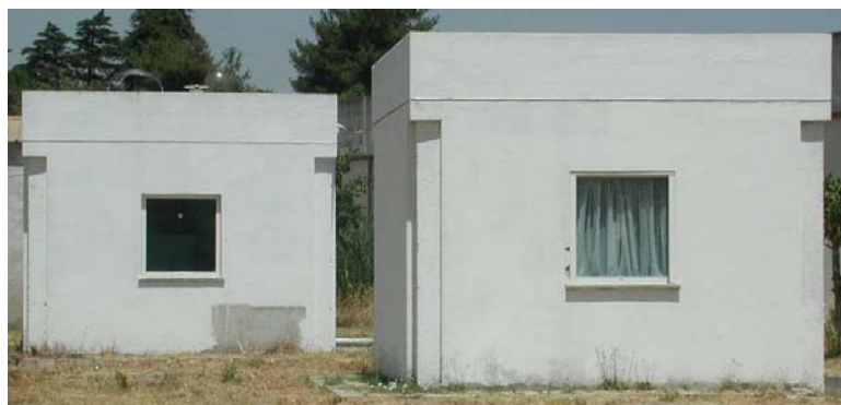
Figura 4.118 - Aspecto exterior das células de teste
