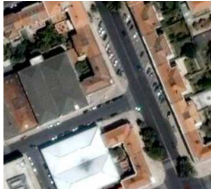
Figura 15 | Fotografias da intersecção da Av. Rio de Janeiro com a Rua João Saraiva
