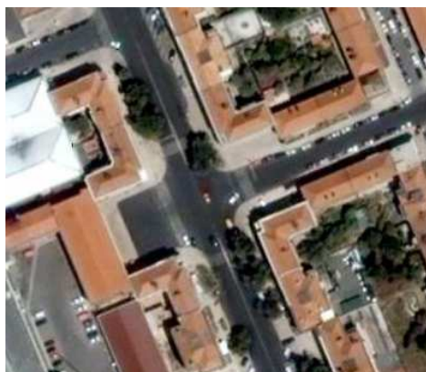
Figura 16 | Fotografias da intersecção da Av. Rio de Janeiro com a Rua Ricardo Jorge
