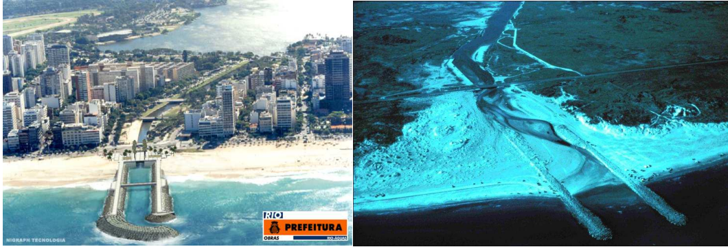
Figura 6 – Exemplos de aplicação de quebra-mares para estabilização de embocaduras: Lagoa Rodrigo de Freitas, Brasil (cortesia da Fundação Rio Águas), e Fish Pass, E.U.A. (Davies e Zarillo, 2003).
