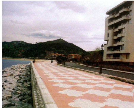
Figura 1 – Exemplo de defesa longitudinal aderente na praia de Castro Urdiales (Cantábria, Espanha).
