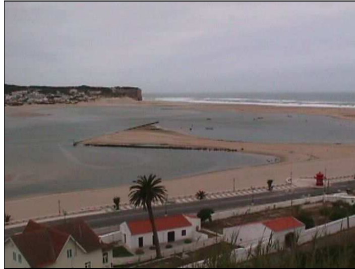
Figura 8 – Dique de guiamento junto à Foz do Arelho, Portugal.
