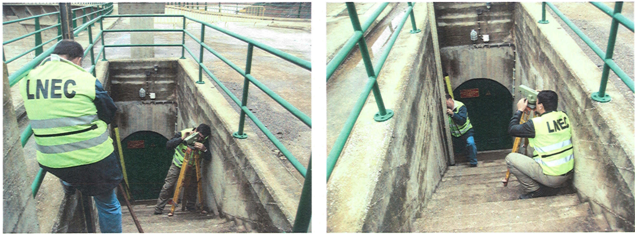
Figura 6 – Entrada de uma linha de nivelamento geométrico numa galeria de inspecção de uma barragem de betão.
