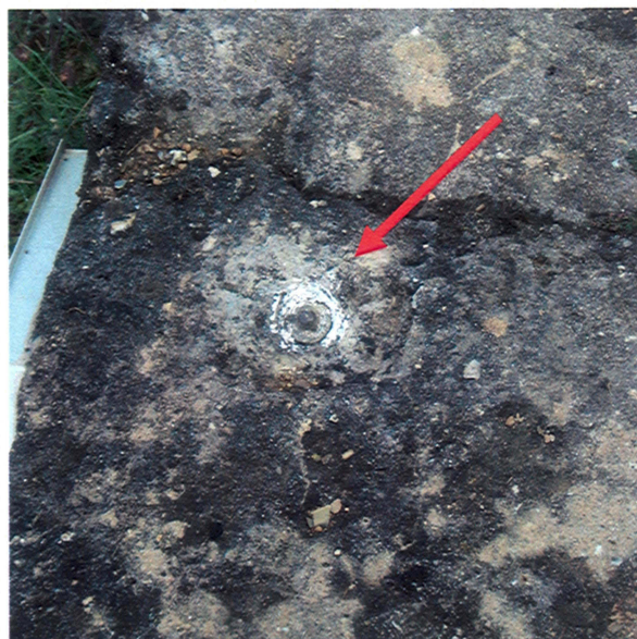
Figura 8 – Marca de nivelamento cravada numa viga de betão.
