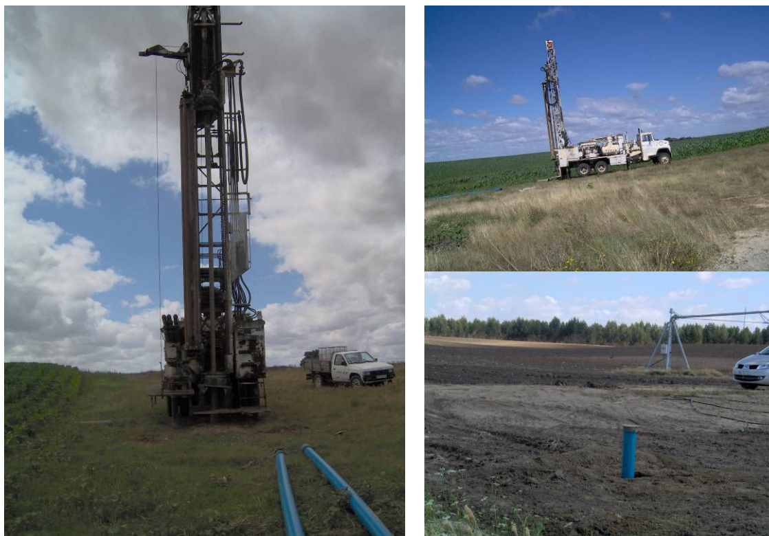
Fig. 7 - Instalação dos piezómetros em 2007 pela firma SulAqua, Lda.
