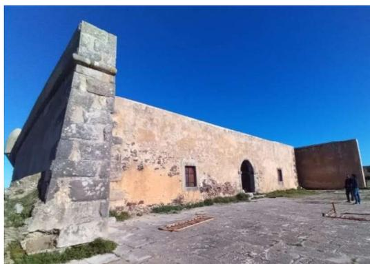
Figura 1 – Forte de Paimogo e o elevado nível de degradação dos rebocos exteriores (2023)
