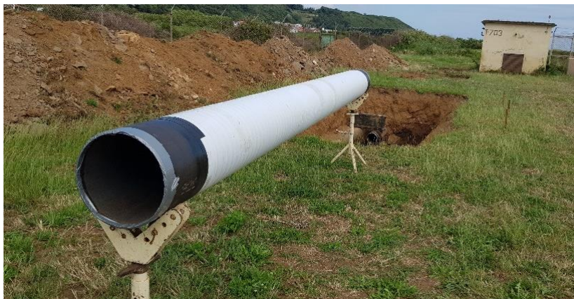
Figura 4.40 – Pormenor da substituição de tubagem do pipeline das Lajes
