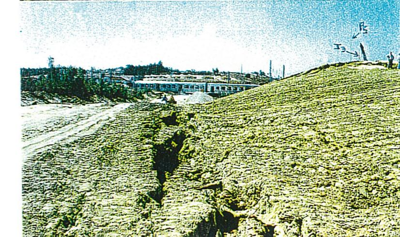
Figura 5.11 - Rotura do aterro Sul da Passagem Superior da Azambuja;
