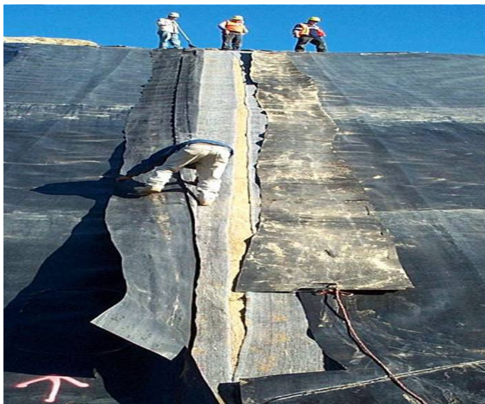
Figura 6 – Painéis adjacentes afastados devido à retracção do GCL no aterro de Southern (Koerner & Koerner, 2005)
