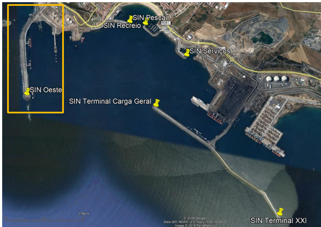
Figura 3. Porto de Sines. Localização das estruturas que integram a metodologia OSOM+ (adaptado de Google Earth, 2020)
