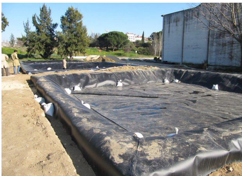
Fig. 6 - Aspeto da fase de construção da instalação piloto
