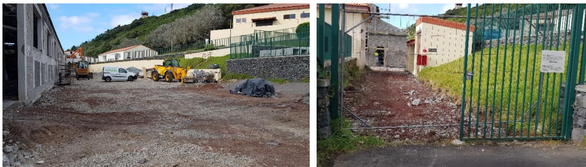
Figura 4.9 – Obra em curso no Site 3003, onde se observa a remoção parcial dos solos (à esquerda: vista nascente do edifício T-624; à direita: vista nascente do edifício T-621)
