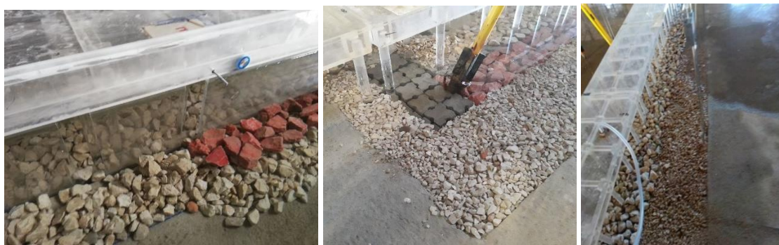
Figura 12. Fase 3. a) Detalhe da cortina de estacas-prancha com aberturas. b) Reforço da secção inicial da proteção da cortina de estaca-prancha com meios cubos Antifer c) Detalhe da ponte-cais sem estacas-prancha.
