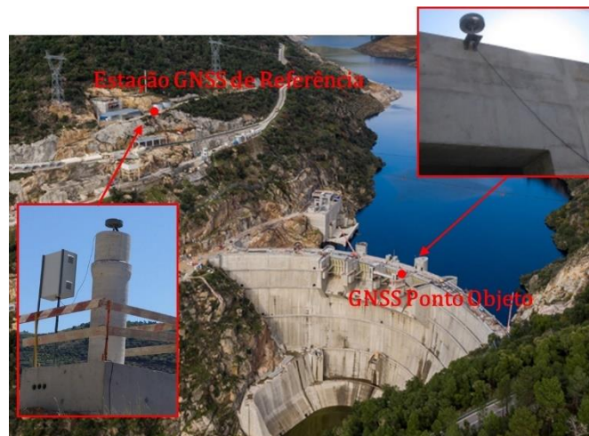
Figura 4. Localização das estações GNSS na barragem de Foz Tua: a estação objeto, no coroamento da barragem, e a estação de referência, na margem direita.
