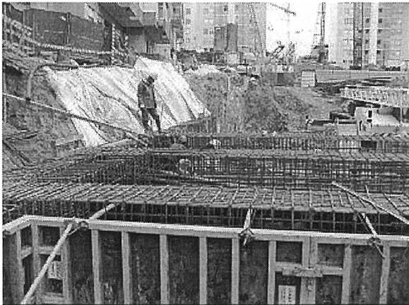
Figura 4. Execução de laje superior
