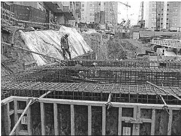
Figura 4. Execução de laje superior
