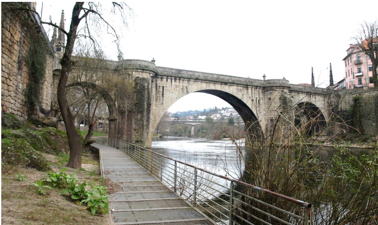
Figura 1. Ponte de São Gonçalo, vista jusante
