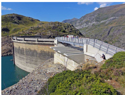
Figura 4.6 | Barragem de Gloriettes (França). Aspecto da soleira PKW
