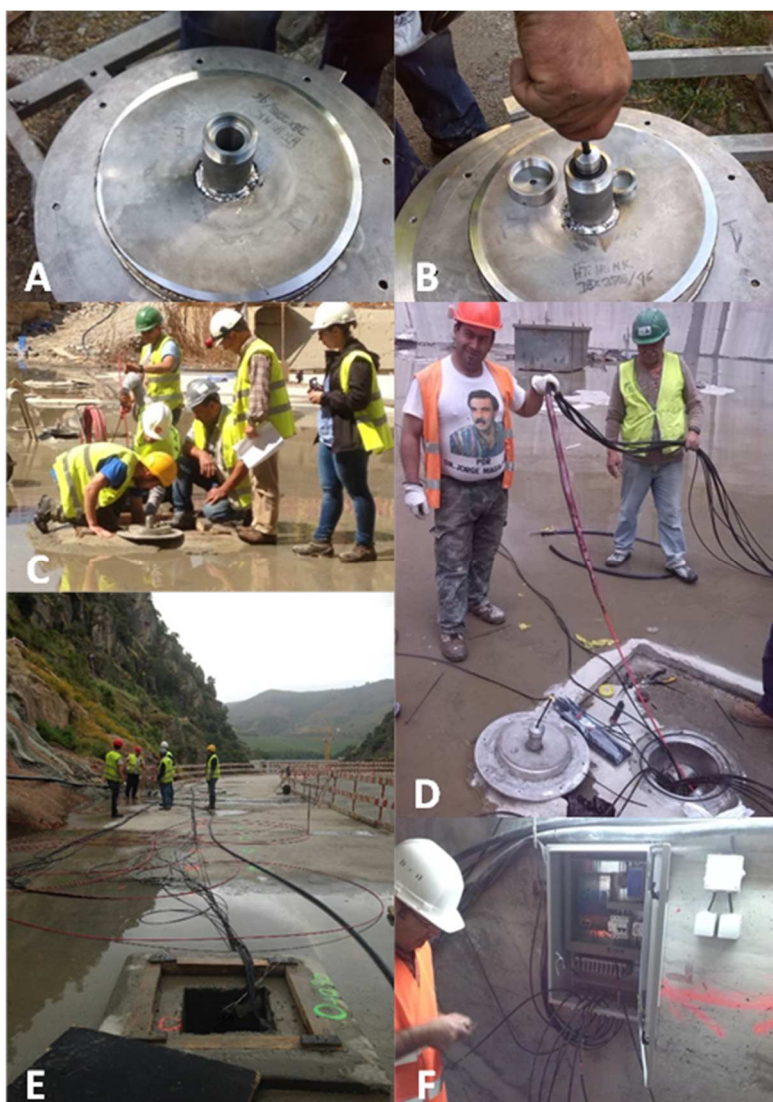
Figura 4.12 | Sequência de instalação dos transdutores de pressão LMK 307 e encaminhamento da cablagem até ao ponto de aquisição de dados (autómato). A e B: colocação do transdutor de pressão na câmara de medição da caixa de proteção; C: encaminhamento da cablagem dos diferentes transdutores pela conduta técnica da cota 72,00 até à caixa nº3; D: junção e encaminhamento de toda a cablagem pela conduta técnica da cota 72,00 até à cota 102,50; E: encaminhamento da cablagem da cota 102,50 até à galeria de visita 4 (GV4); F: ligação da cablagem individualizada aos canais predefinidos no autómato de aquisição de sinal
