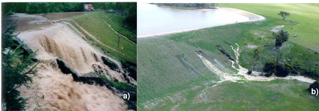
Figura 4.2 | Rotura de aterros: a) galgamento; b) piping
