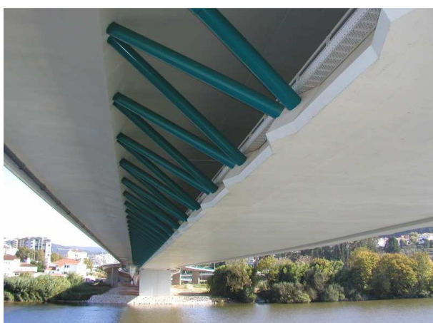
Figura 2 – Vista inferior do tabuleiro
