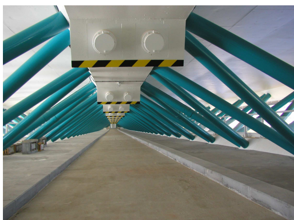
Figura 3 – A laje inferior e a treliça metálica
