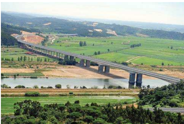
Figura 1 Vista geral da ponte sobre o rio Mondego (foto cedida pela LACE)
