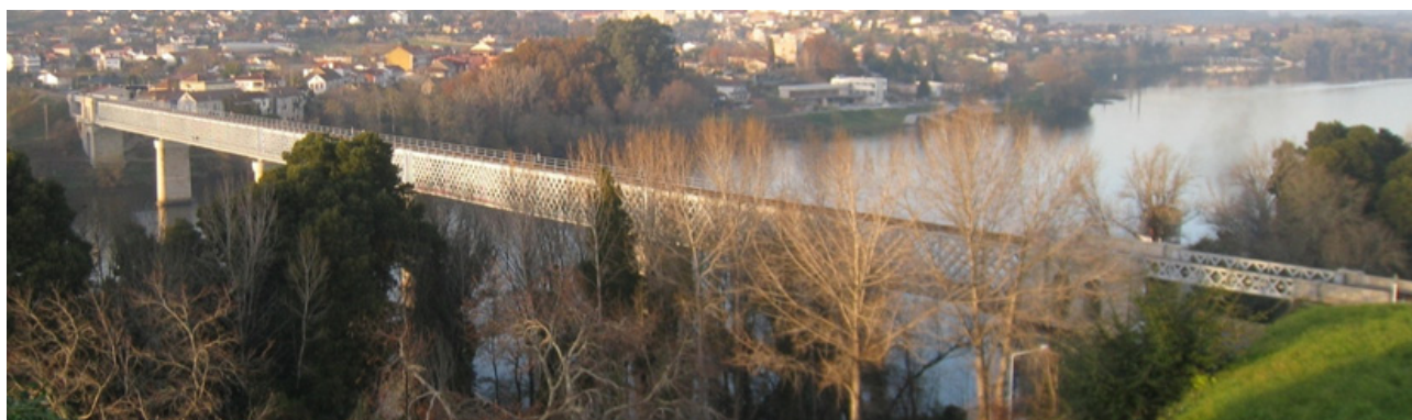
Figura 1 Ponte Internacional de Valença
