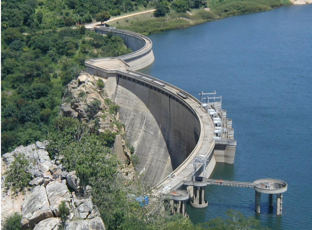
Figura 2: Barragem da Chicamba. Vista da margem esquerda
