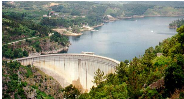
Figura 3. Barragem do Cabril.
